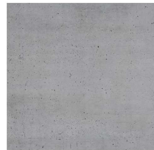
Soutènement béton brut
