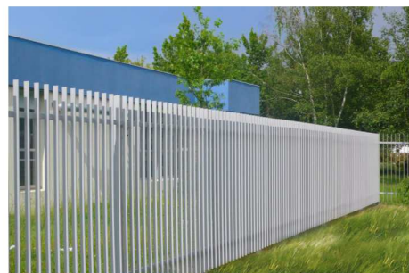
Clôture barreaudée en serrurerie
