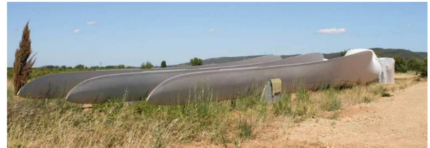
Figure 56 : Exemple de stockage de pale sur site (Source : JPee)
