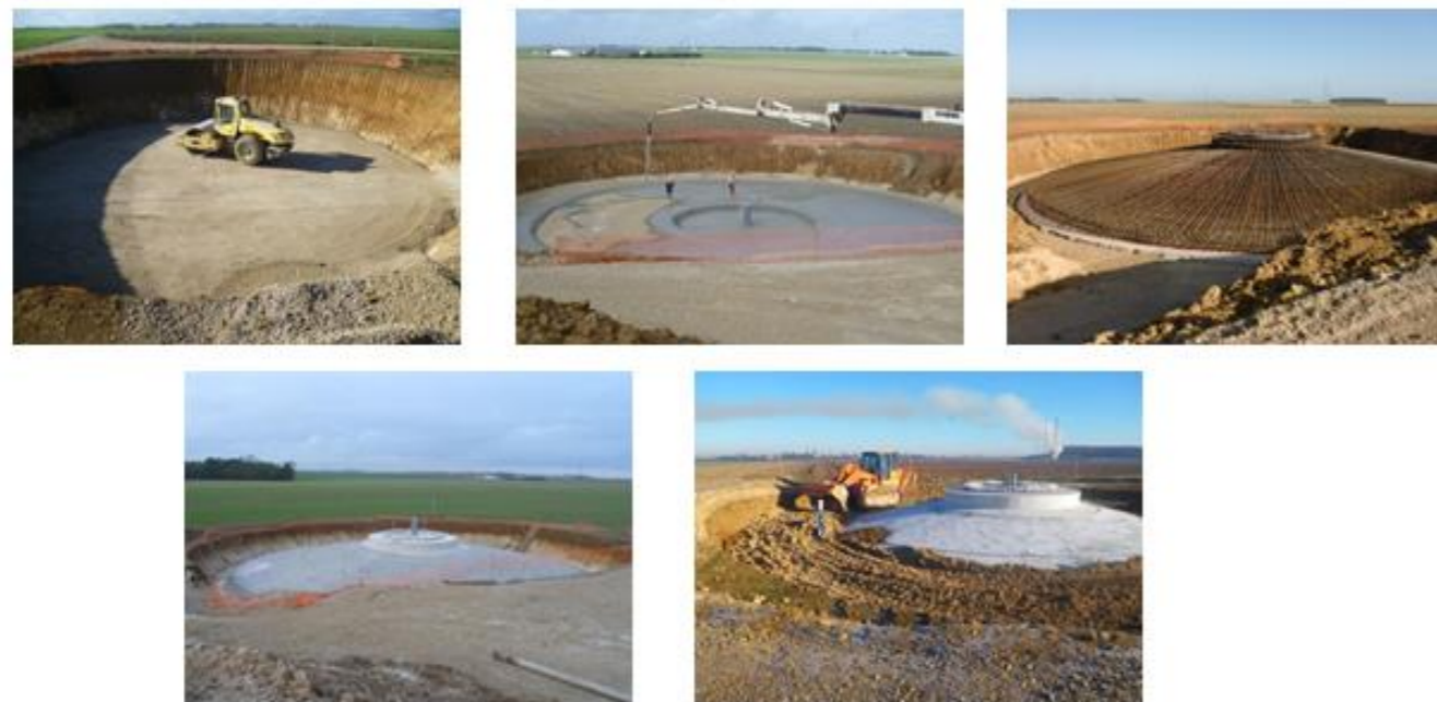
Figure 57 : Photographies de la réalisation des fondations (Source : JPee)
