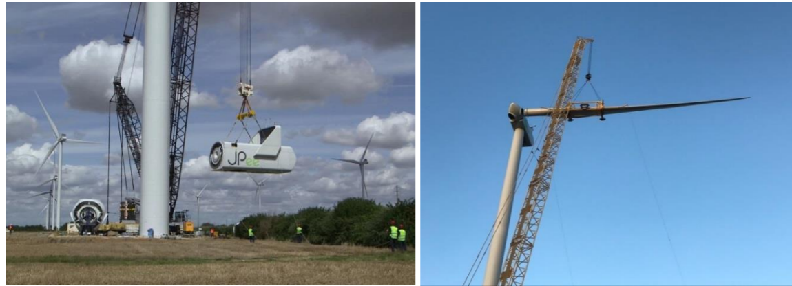
Montage de la nacelle
