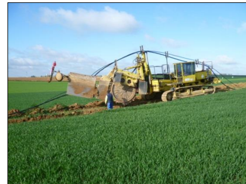
Figure 59 : Photographie d'une opération de raccordement (trancheuse) (Source : JPee)
