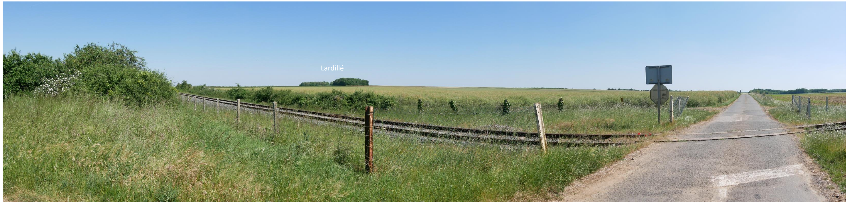
Vue O : Vue depuis la voie de chemin de fer (au niveau du lieu-dit les Couesses), à l'ouest de la ZIP, en direction du sud-est de la ZIP
