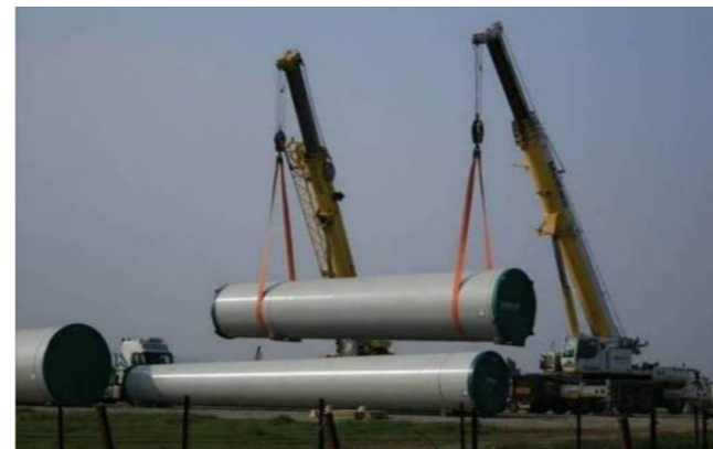
Figure 55 : Aire de grutage et déchargement des tronçons d'un mât (Source : JPee)
