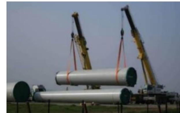
Figure 18 : Aire de grutage et déchargement des tronçons d'un mât
