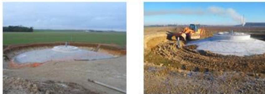
Figure 19 : Photographies de la réalisation des fondations
