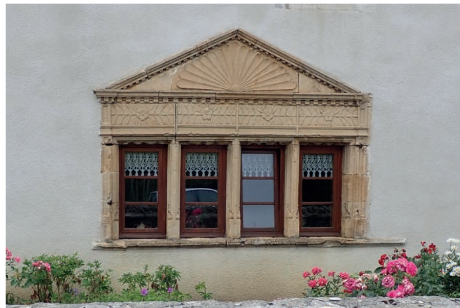
La fenêtre de style renaissance, au rez-de-chaussée de la façade sud-est
