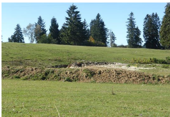
Comblement d'une doline au bord de la RD242
