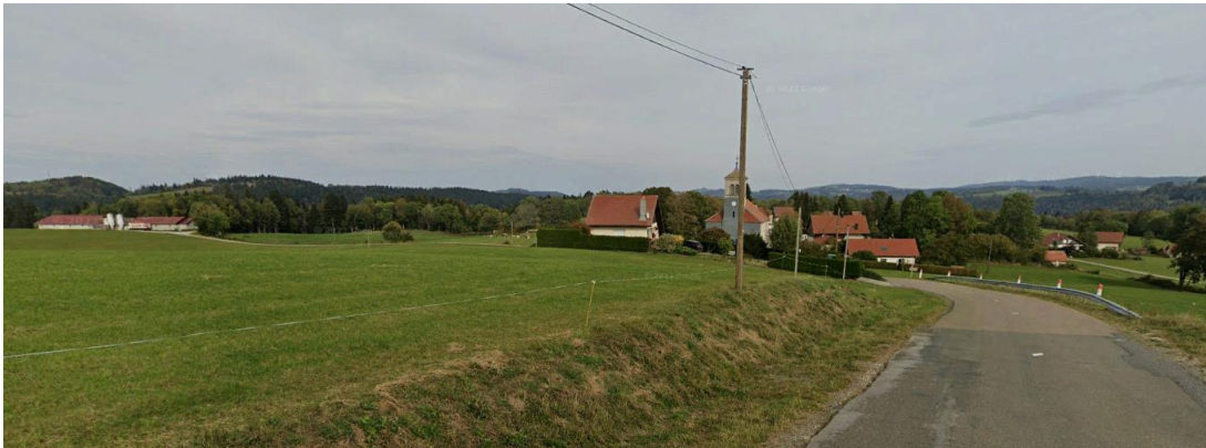
Photo Vue 1 Entrée ouest : Rue principale de Grand'Combe-des-Bois (source : IAD).
