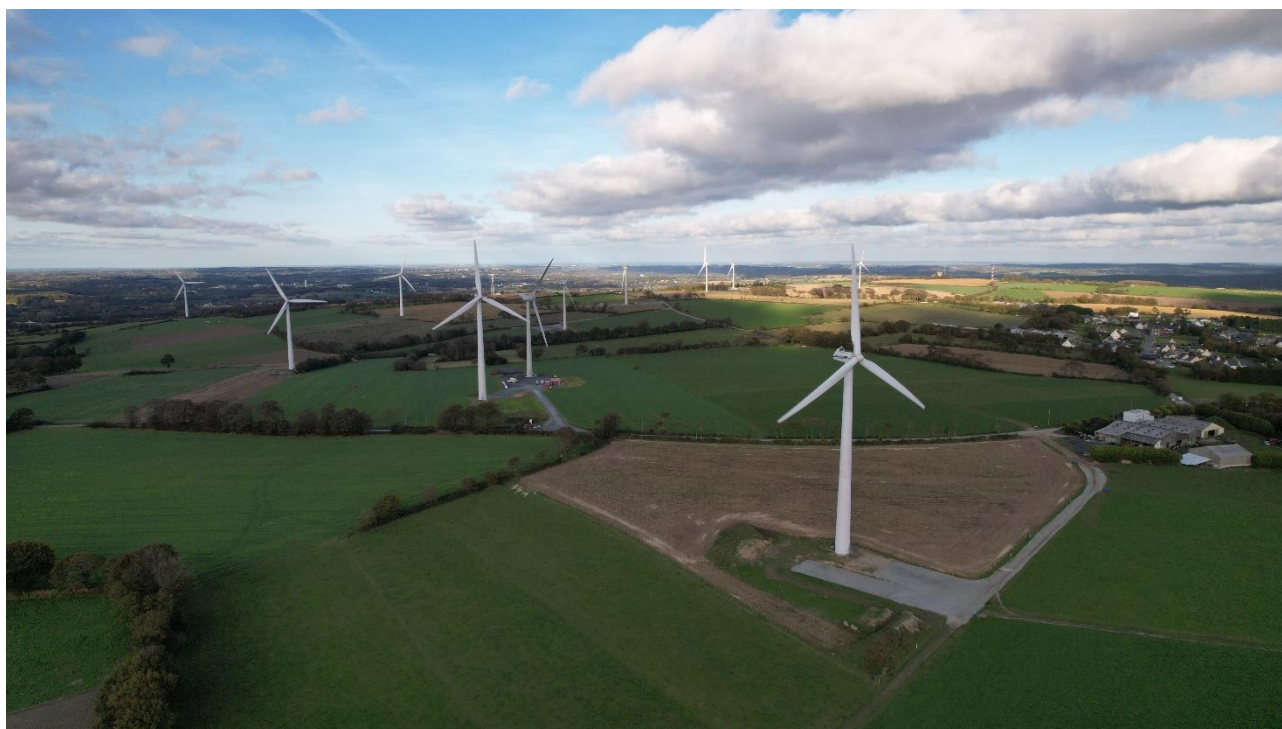
Figure 4 : Les 11 éoliennes de Lanfains entre le montage des nouvelles et le démontage des anciennes
