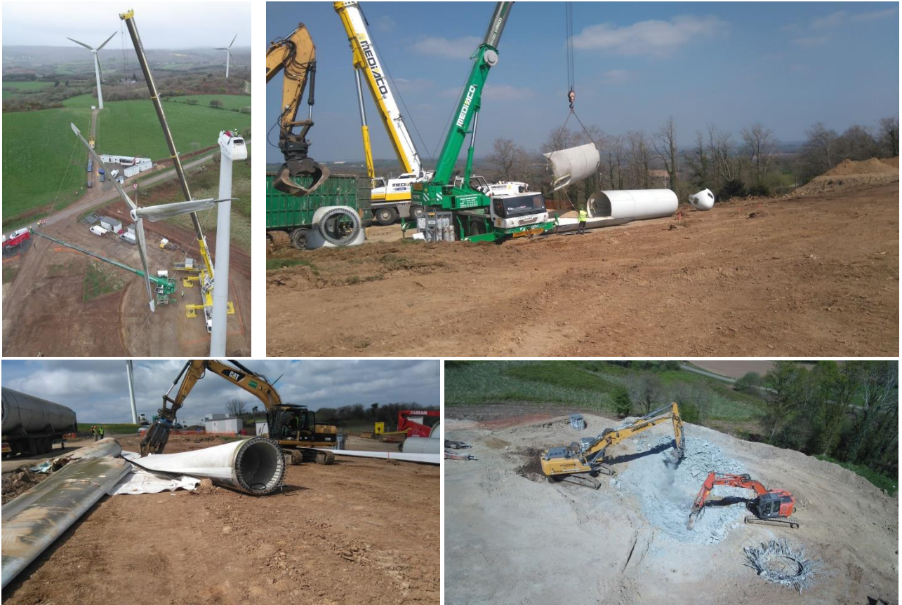
Figure 7 : Démantèlement du parc éolien de Plouyé (démontage de l'éolienne, cisailage de la pale, destruction de la fondation)
