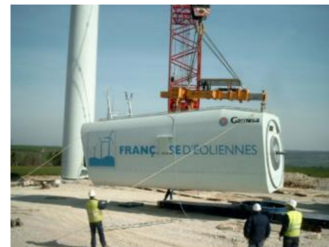
Figure 90 : Hissage de la nacelle
