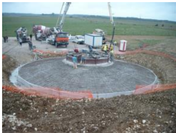
Figure 86 : Coulage de la fondation
