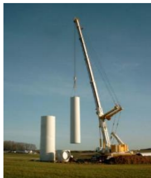
Figure 89 : Assemblage de la deuxième section de la tour
