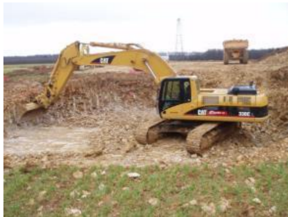
Figure 85 : Fouille de la fondation
