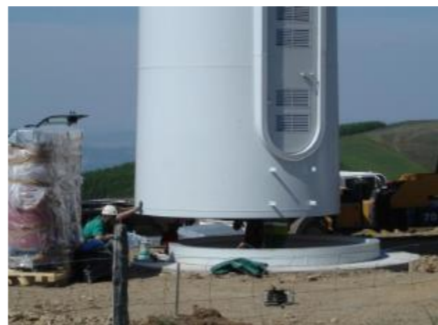
Figure 88 : Assemblage de la première section de la tour
