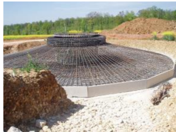
Figure 87 : Ferrailage de la fondation
