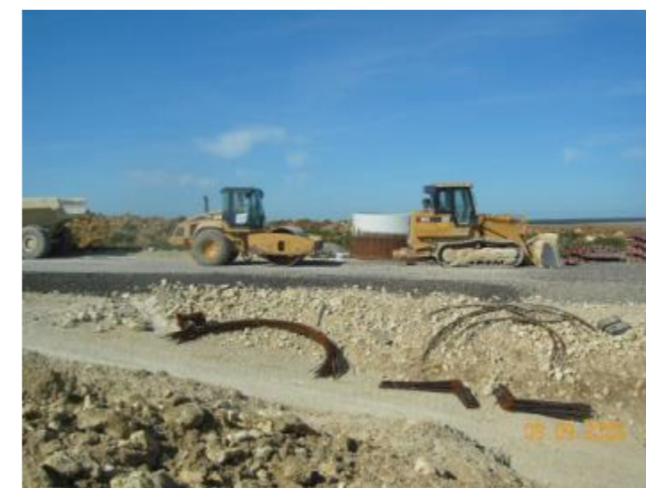
Figure 83 : Aplanissement du terrain
