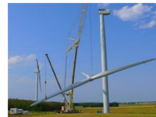
Figure 92 : Hissage du rotor complet
