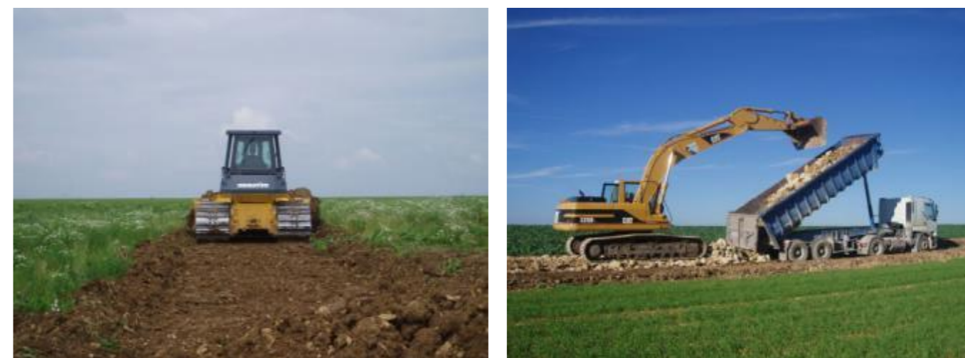
Figure 84 : Mise en forme des chemins d'accès
