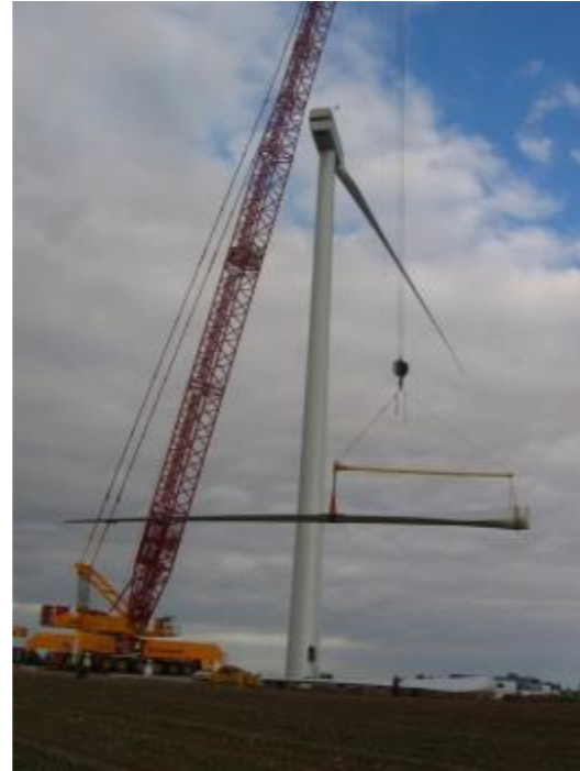
Figure 93 : Système de levage d'une pale
