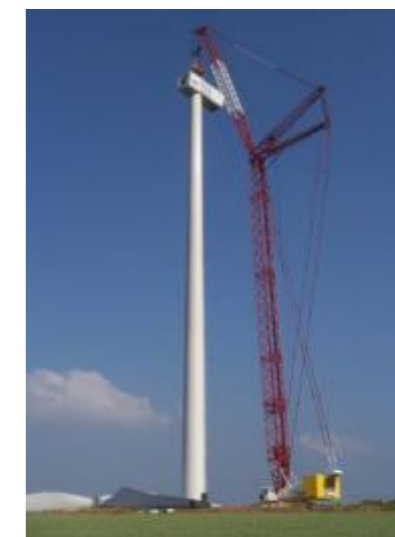
Figure 91 : Fixation de la nacelle sur la tour
