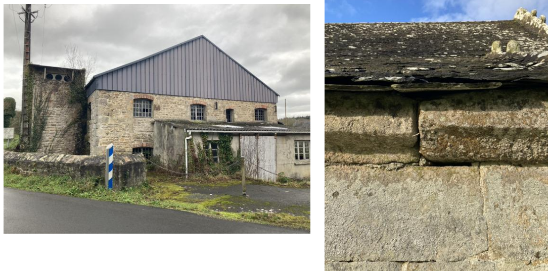
Figure 53. Bâtiments occupés par des chauves-souris (à gauche l'ancien moulin de Traou Hi et à droite un interstice de la chapelle St-Yves)
