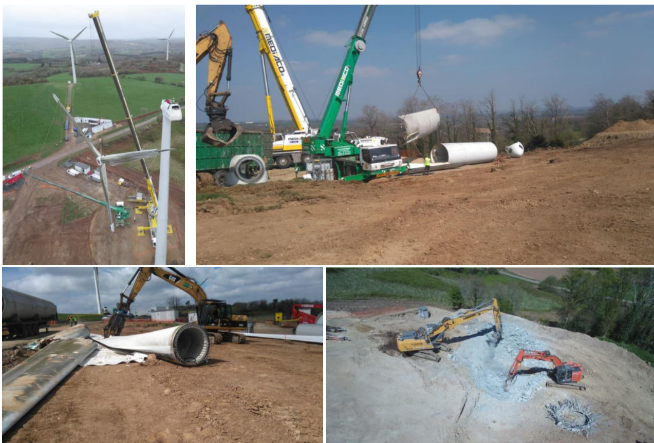
Figure 3 : Démantèlement du parc éolien de Plouyé (démontage de l'éolienne, cisailage de la pale, destruction de la fondation)
