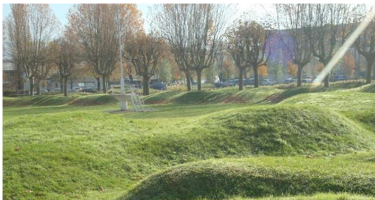
Visuel du type de prairie d'infiltration des EP qui sera mise en œuvre
