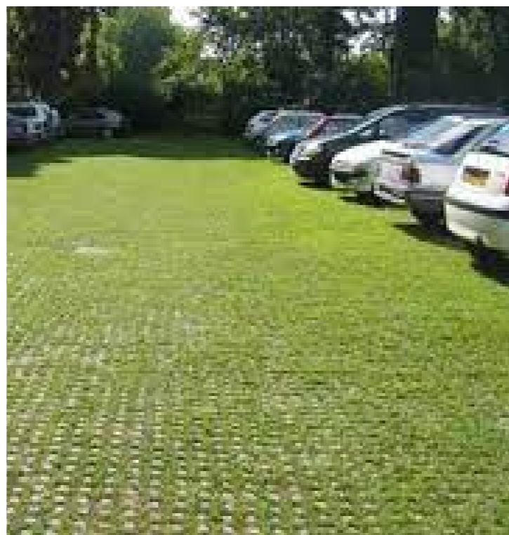
Parking, garage à vélo, zone détente,... : Pavés béton infiltrants enherbés ou avec concassé
