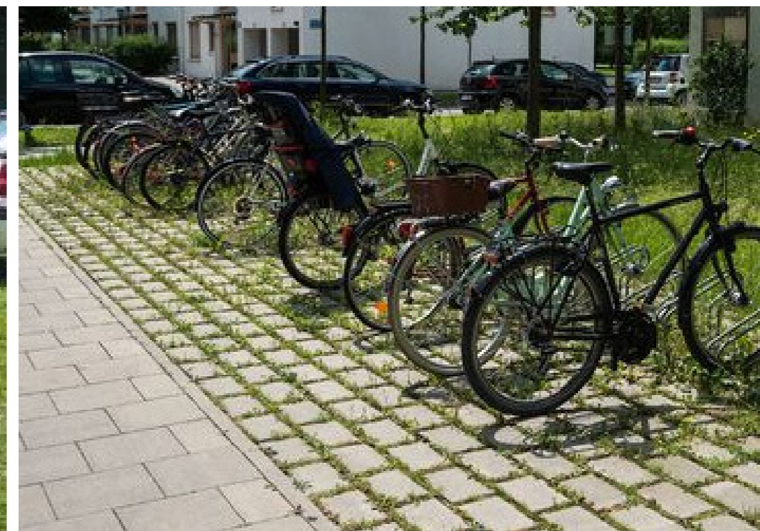
Parking, garage à vélo, zone détente,... : Pavés béton infiltrants enherbés ou avec concassé
