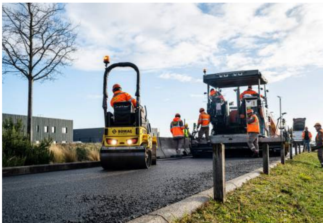
Circulation et place PMR : Enrobé bas carbone
