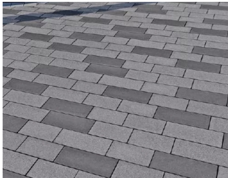
Entrée de bâtiment : pavé sur sable
