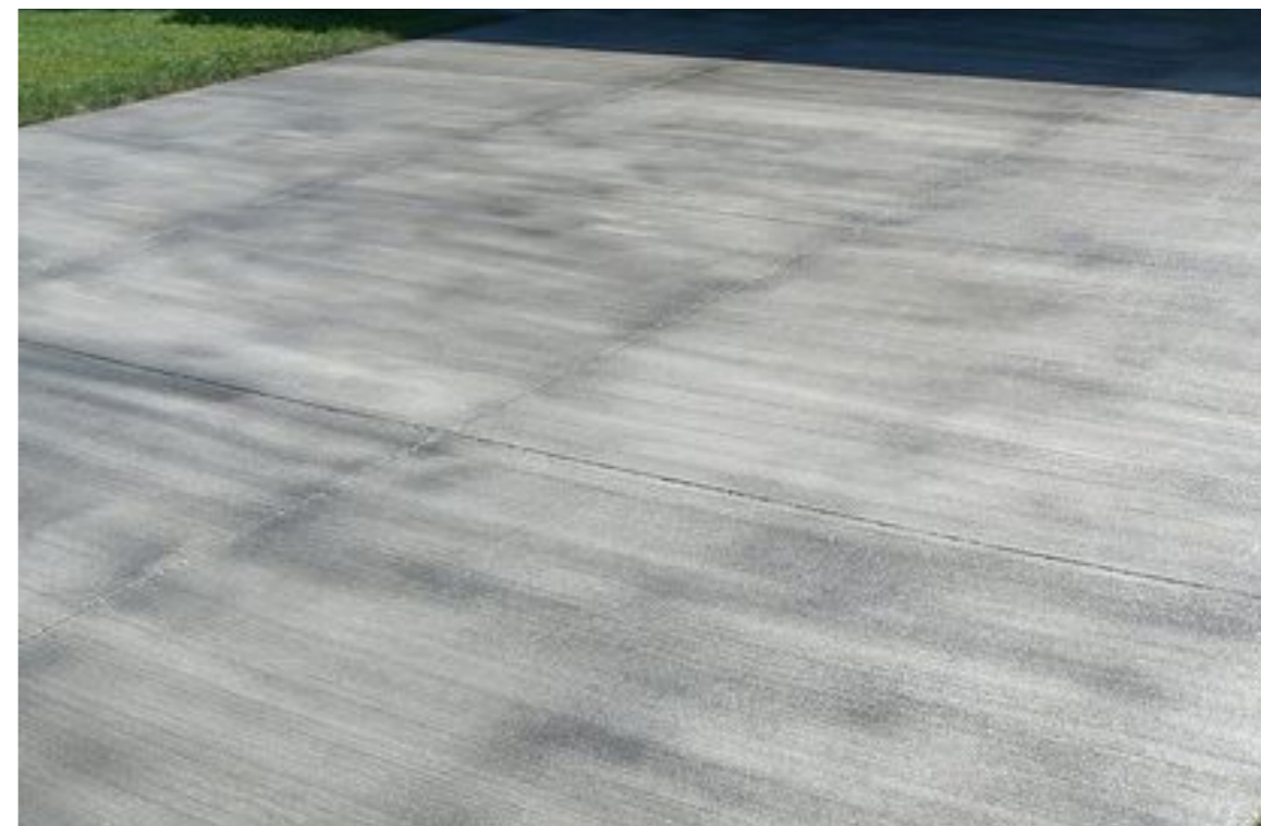
Entrée de bâtiment : Béton coulé en place
