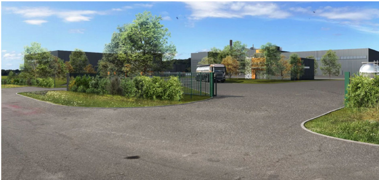
Vue depuis l'entrée du site allée Pierre-Gilles de Gennes
