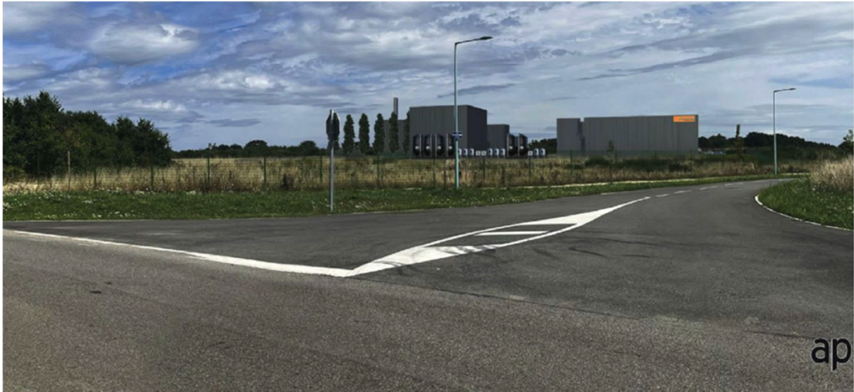
Vue depuis l'entrée de la ZAC
