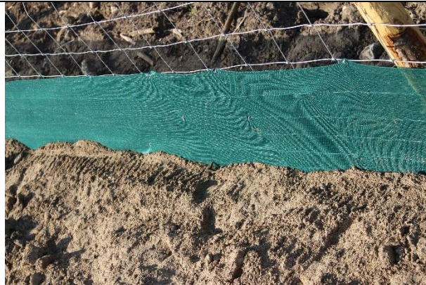
Exemples de filets de protection de la petite faune terrestre mis en place au niveau des clôtures d’un chantier (ATTENTION, il ne s’agit pas ici de dispositifs « à sens unique »)
