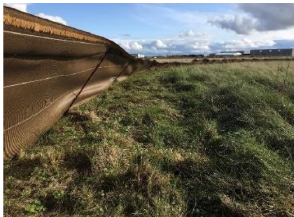
Exemples de filets de protection à sens unique et incliné de la petite faune terrestre mis en place au niveau d’un chantier
