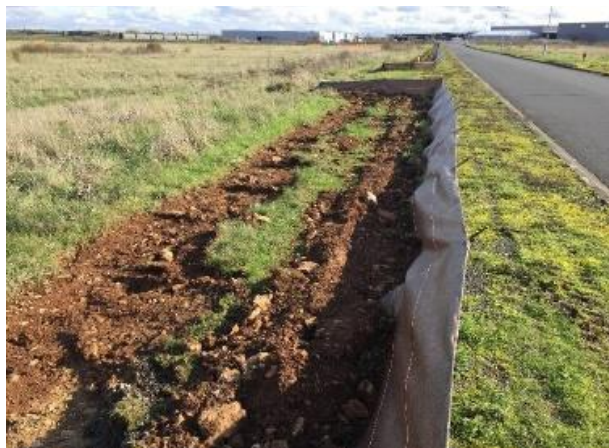
Exemples de filets de protection à sens unique et incliné de la petite faune terrestre mis en place au niveau d’un chantier
