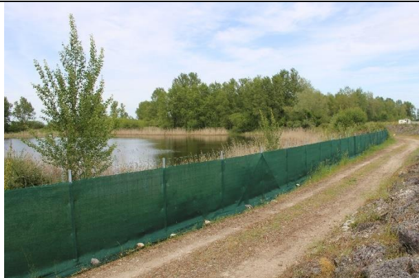
Exemples de filets de protection de la petite faune terrestre mis en place au niveau des clôtures d’un chantier (ATTENTION, il ne s’agit pas ici de dispositifs « à sens unique »)
