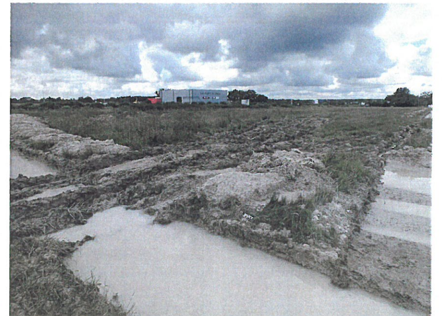
Figure 15 État des conditions de circulation et surtout de la détérioration des sols par le passage de la pelle
