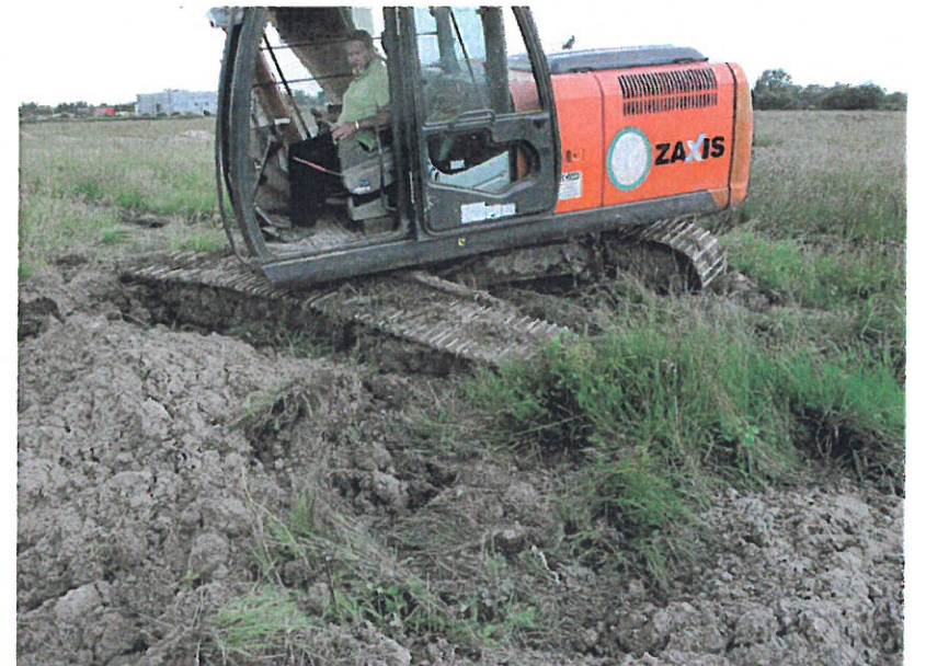
Figure 20 Conditions de terrassement dans la parcelle sud-est de l'emprise. Les sédiments liquéfiés coulent en fond de tranchée. Au premier plan, une fosse d'essouchement.
