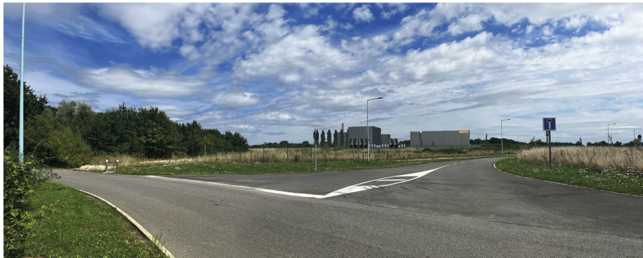
Vue depuis l'entrée de la ZAC
