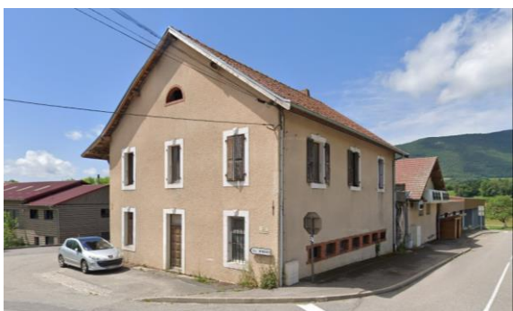
Localisation de la construction et photographie.
