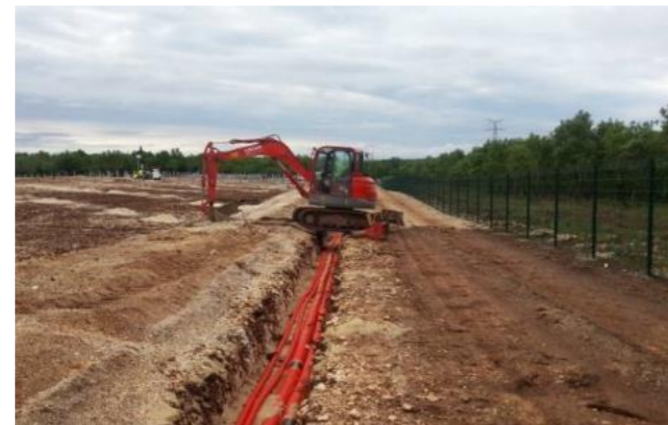
Figure 29 - Exemple de tranchée pour la mise en place des câbles électriques
