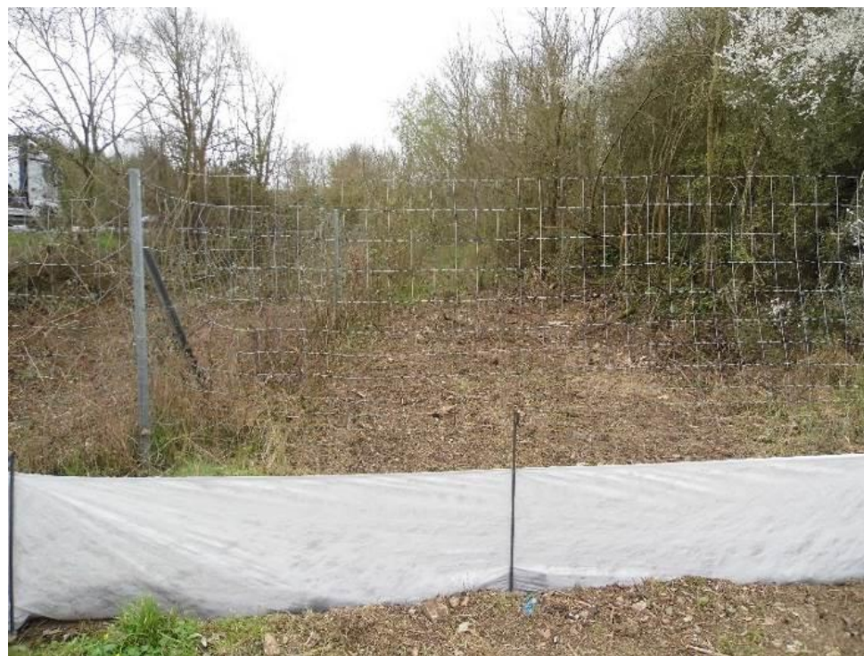
Figure 135 – Illustration de barrières en géotextile disposées en partie basse de clôtures de chantier
