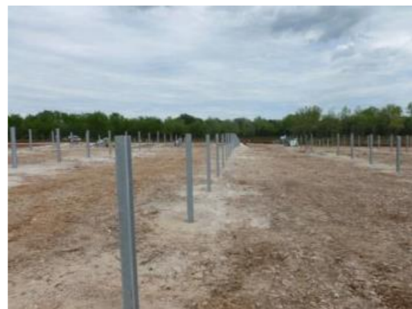
Figure 28 : Mise en place des structures type pieux battus (PHOTOSOL)
