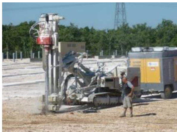
Figure 28 : Mise en place des structures type pieux battus (PHOTOSOL)
