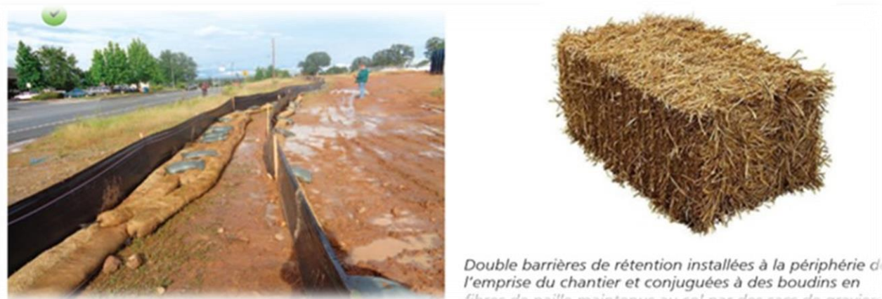
Figure 136 – Exemple d'utilisation de barrières type « boudins de paille » (Source Biotope)
