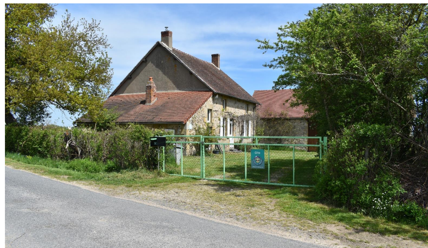
Photographie 19 - Gîte La Rondière au niveau de la limite ouest de la ZIP est - source : Eco-Stratégie, le 28.04.22
