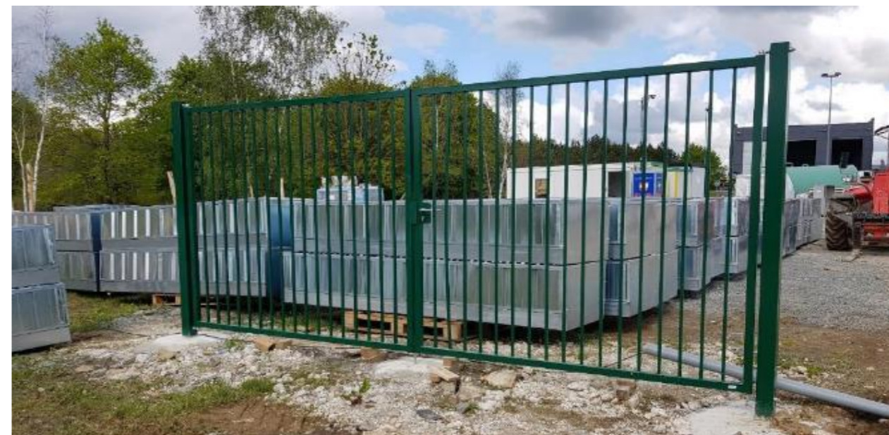
Figure 25 – Exemple de clôtures et portail (source : PHOTOSOL)
