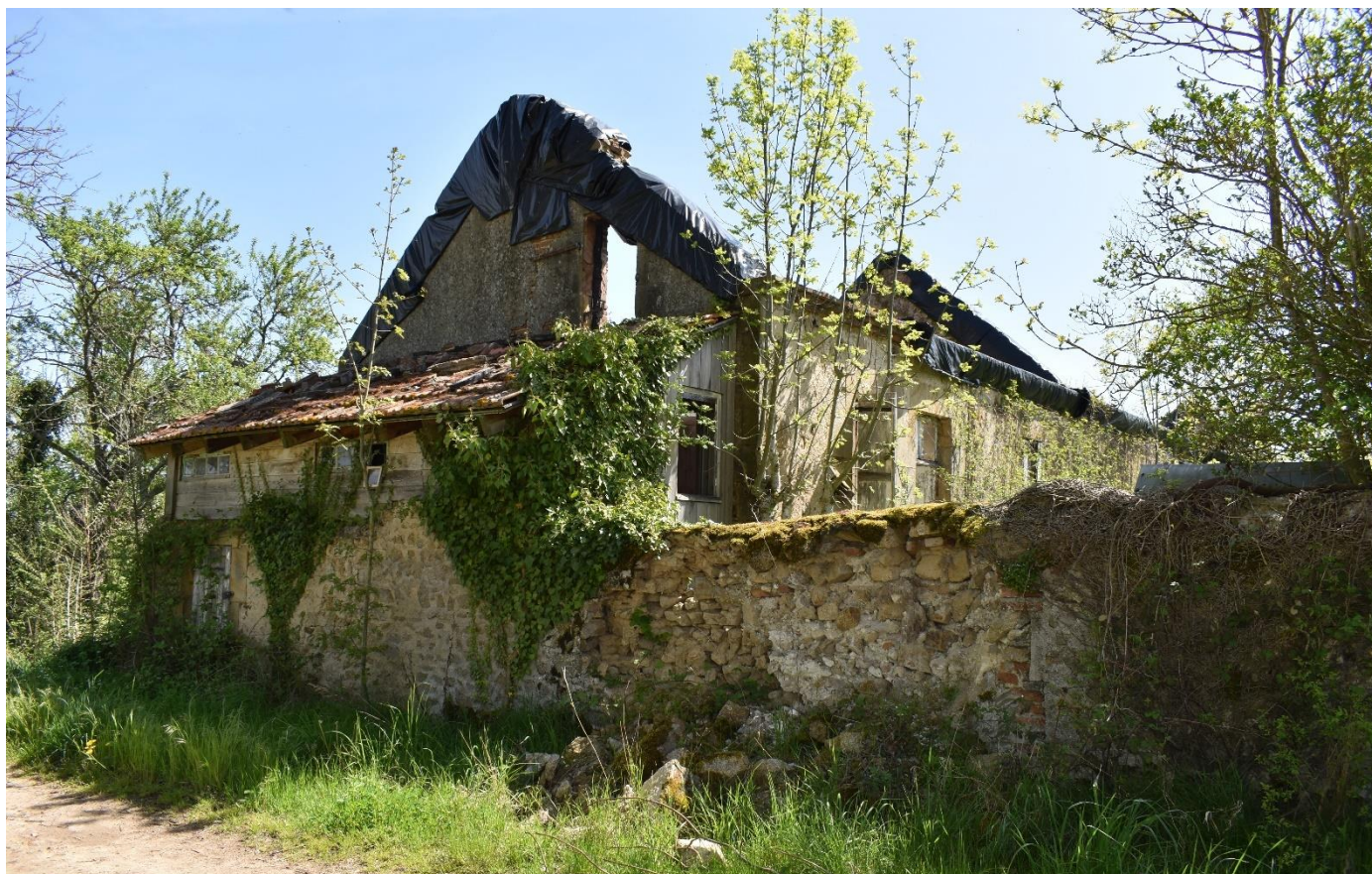
Photographie 20 - Ruine située à l'entrée ouest de la ZIP est - source : Eco-Stratégie, le 28.04.22
