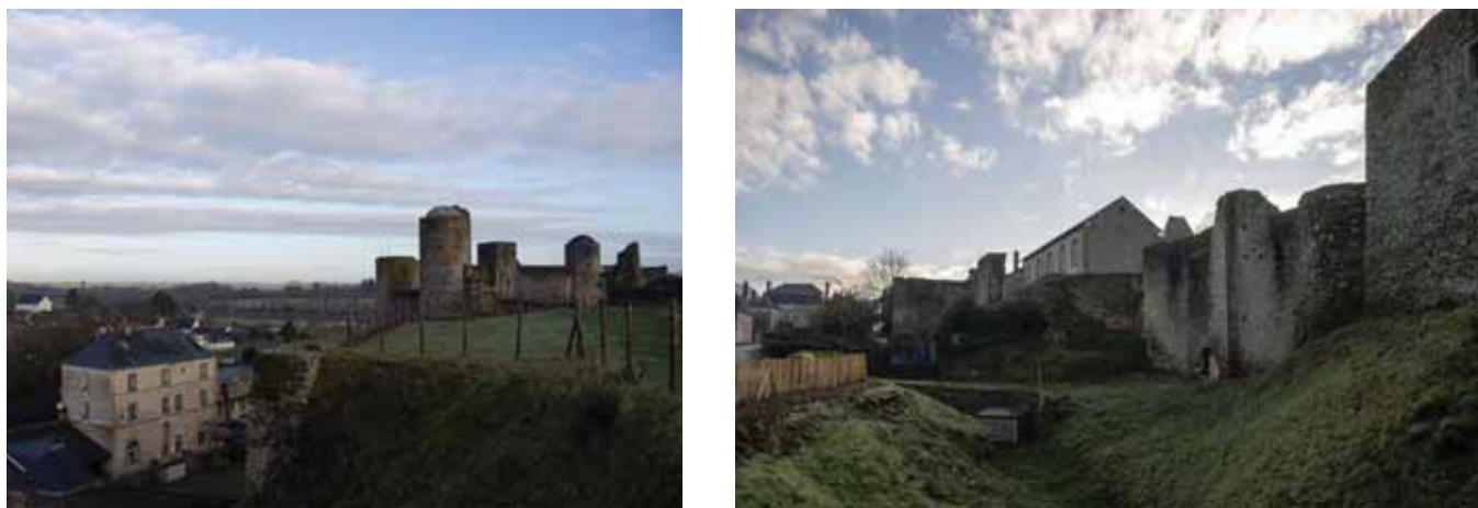
Photo 25. Château de Pouancé
