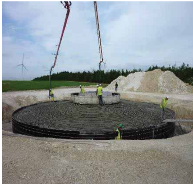
Figure 43. Construction d'une fondation
