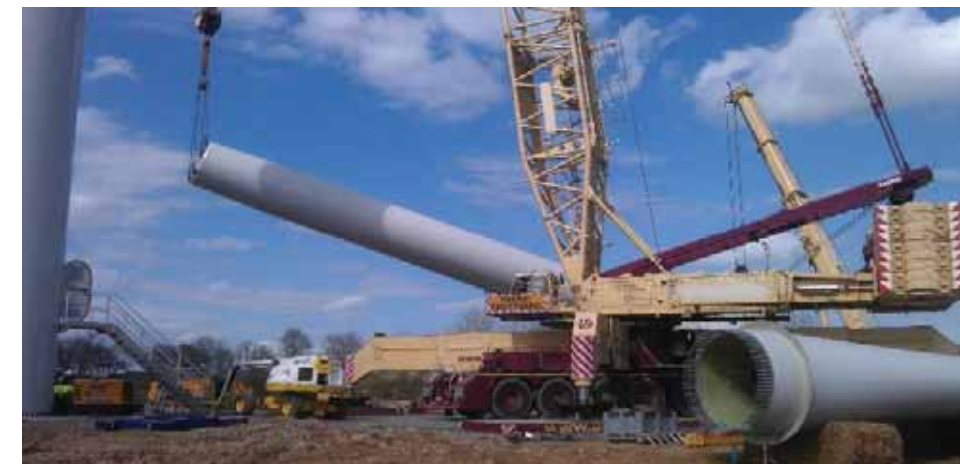
Photo 33. Grue de levage pour plateforme
