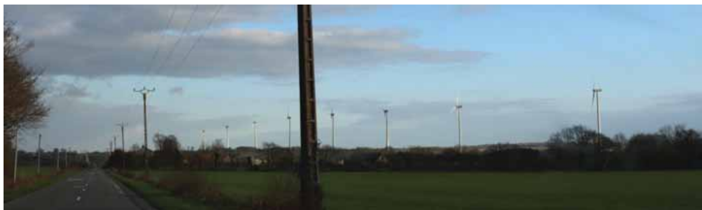
Photo 18. Parc éolien des Coteaux
