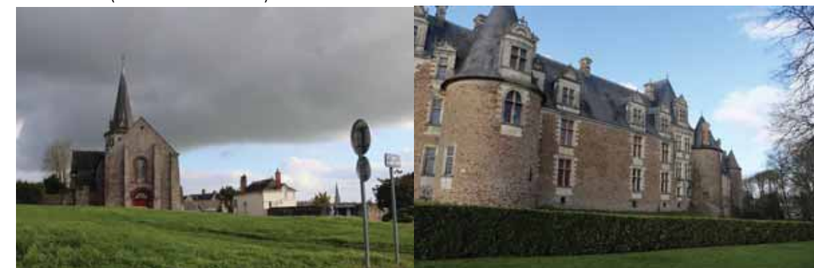
Photo 23. Eglise de Saint-Jean-de-Béré et Château de Châteaubriant
