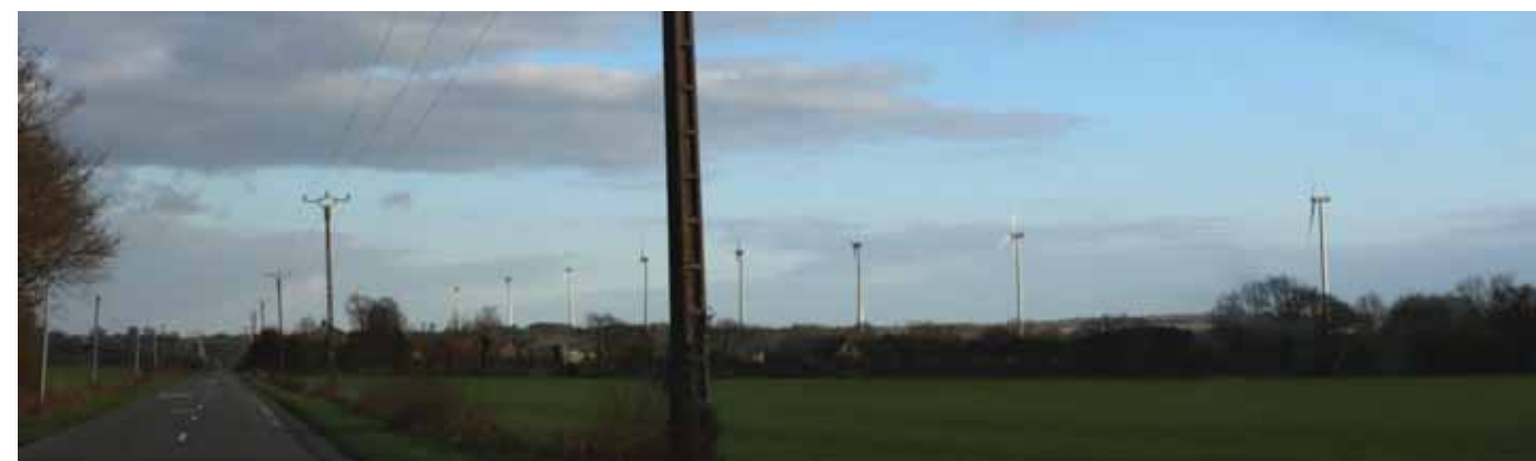
Parc éolien des Coteaux
