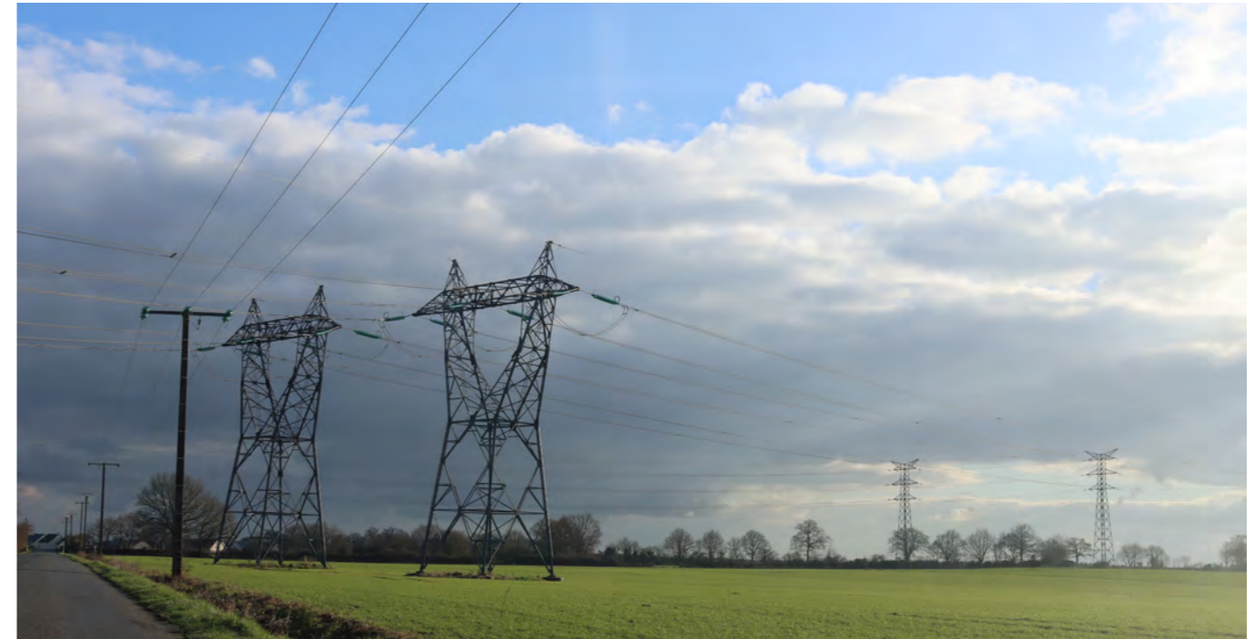
Photographie 8. Lignes électriques
