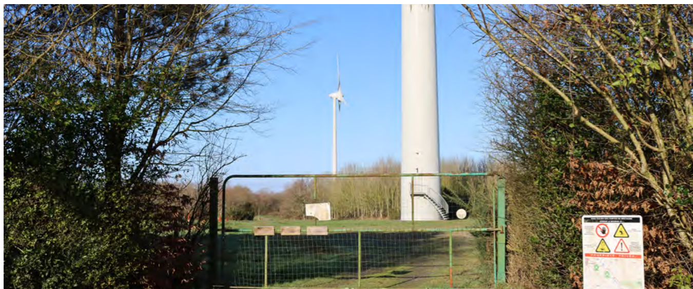
Photographie 65. Parc éolien de Soudan
