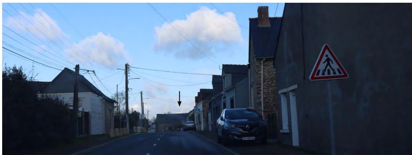
Photographie 43. Bourg la Touche (éolienne du Parc de Soudan)
