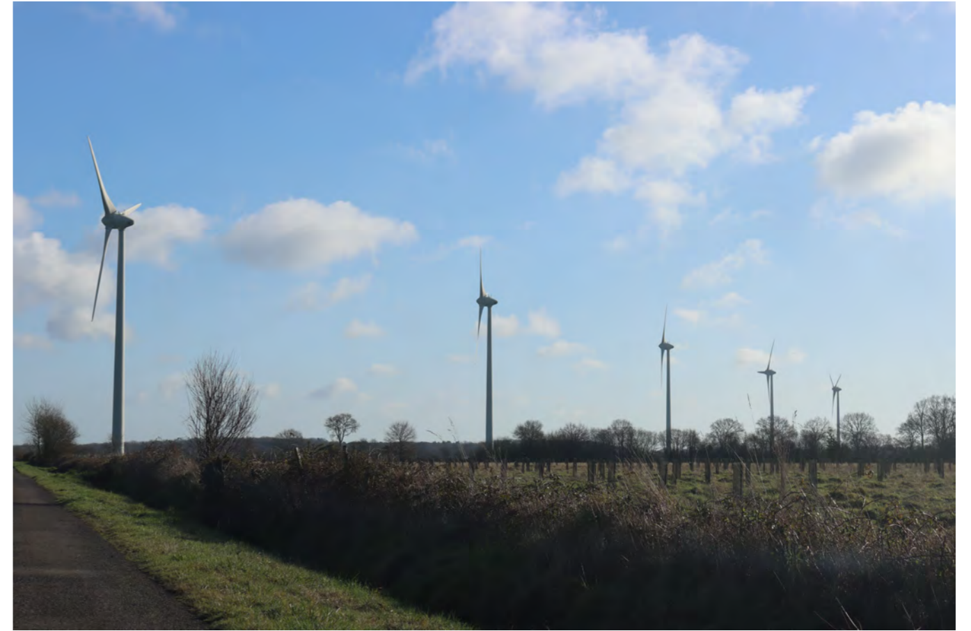
Photographie 73. Chemin d'accès ZIP Erbray I
