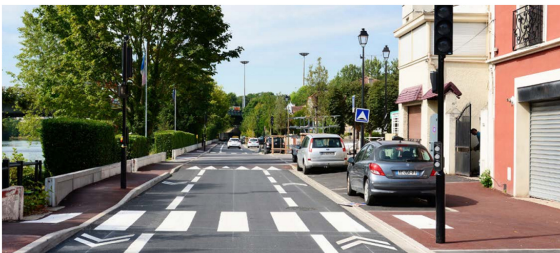
Exemples de traitement d'une rue avec le système Chacidou et stationnement latéral (Rue centrale du Mont Aval)
