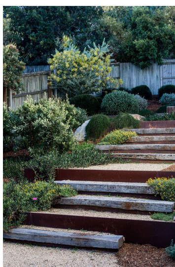
Exemple d'allées piétonnes dans des pentes fortes, illustrant des escaliers paysagés (les traverses)
