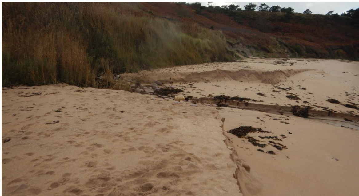
Fig. 46. Côte basse meuble sur la plage du Portuais
