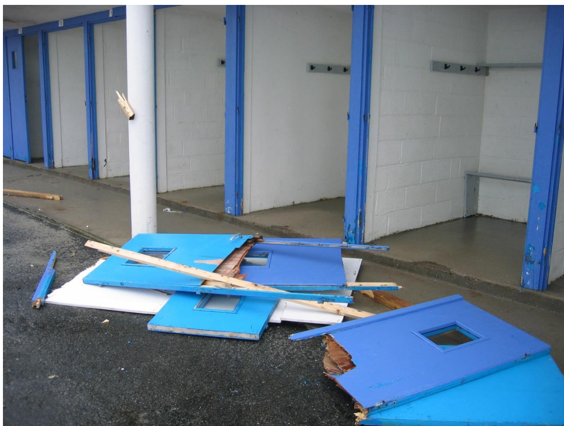
Fig. 27. Exemple de dégâts provoqués par des projections lors de la tempête du 10 mars 2011 à Perros-Guirec
