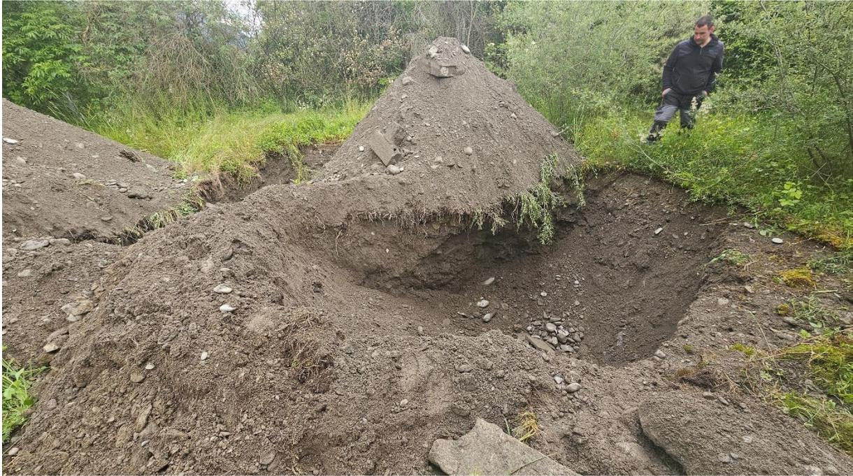
*Figure 39 : Mise en œuvre des sondages à l'emplacement supposé des cuves*
