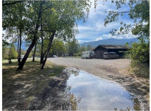
Ancienne entrée de l'aérodrome – démolition enrobé et transformation en voie verte
