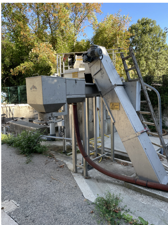
> Dégrilleur automatique - maille 2 mm
