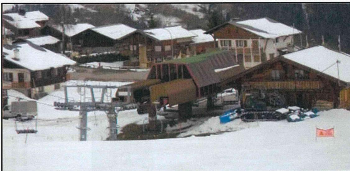
L'installation en projet est à l'inverse basée sur un positionnement de la gare motrice à l'amont dans une zone plus ouverte et moins urbanisée. Ceci permettra une réduction significative du niveau sonore au niveau de la zone fortement urbanisée à proximité du front de neige en gare aval. Seuls les sons résultats du frottement des attaches des véhicules sur les rampes d'embrayage et débrayage de la gare seront perceptibles en gare aval.
