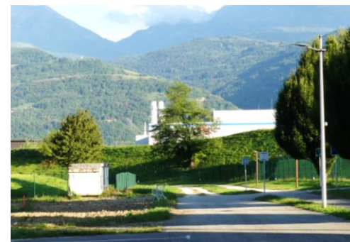
3 : Talus de ST Microélectronics
