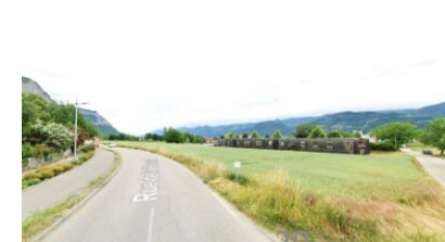
Vue rue de la Bouverie
