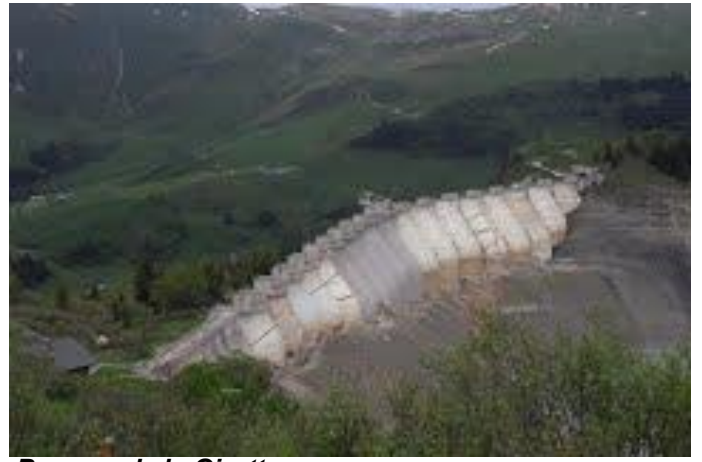
Barrage de la Girotte
