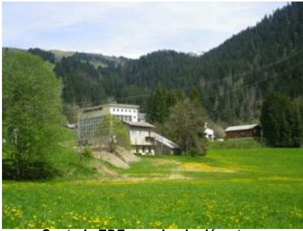
Centrale EDF, proche du départ des pistes du domaine des Contamines
