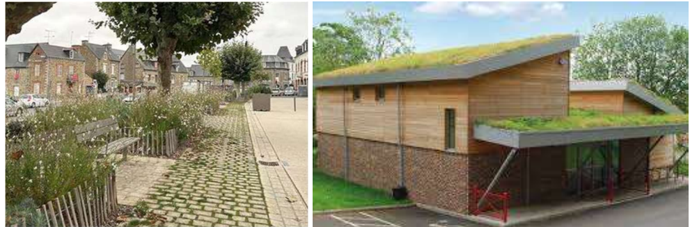
Aménagement en pavés enherbés sur les Terrasses du Haras
