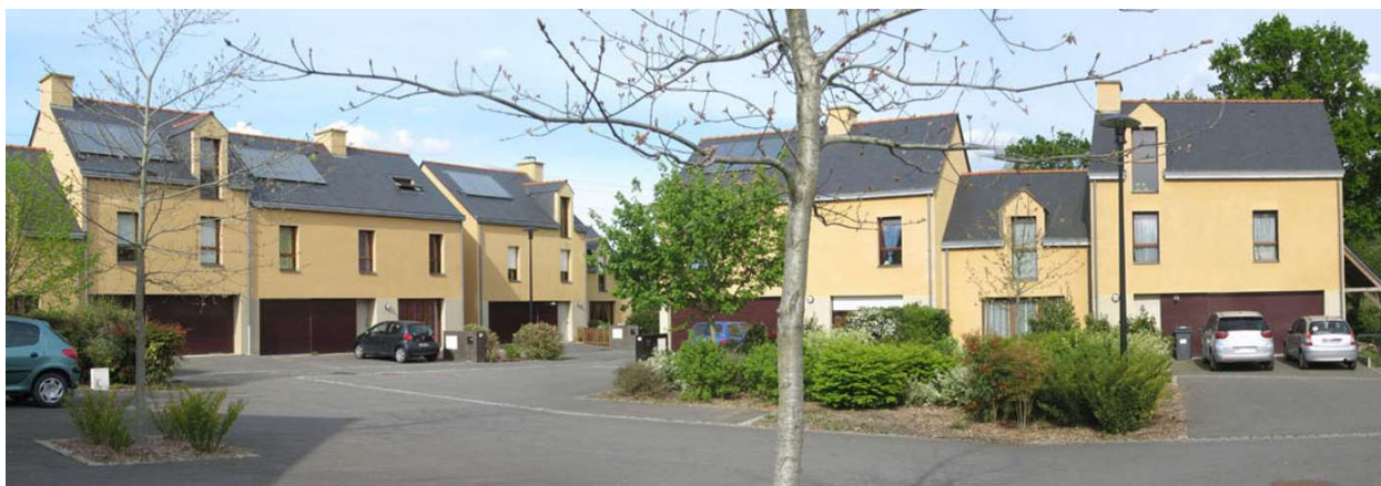
Maisons individuelles groupées à Acigné (Ille-et-Vilaine)
