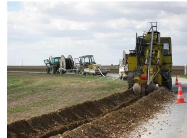
**Figure 50 : Réalisation de tranchées du raccordement externe dans l'emprise des voies existantes**
