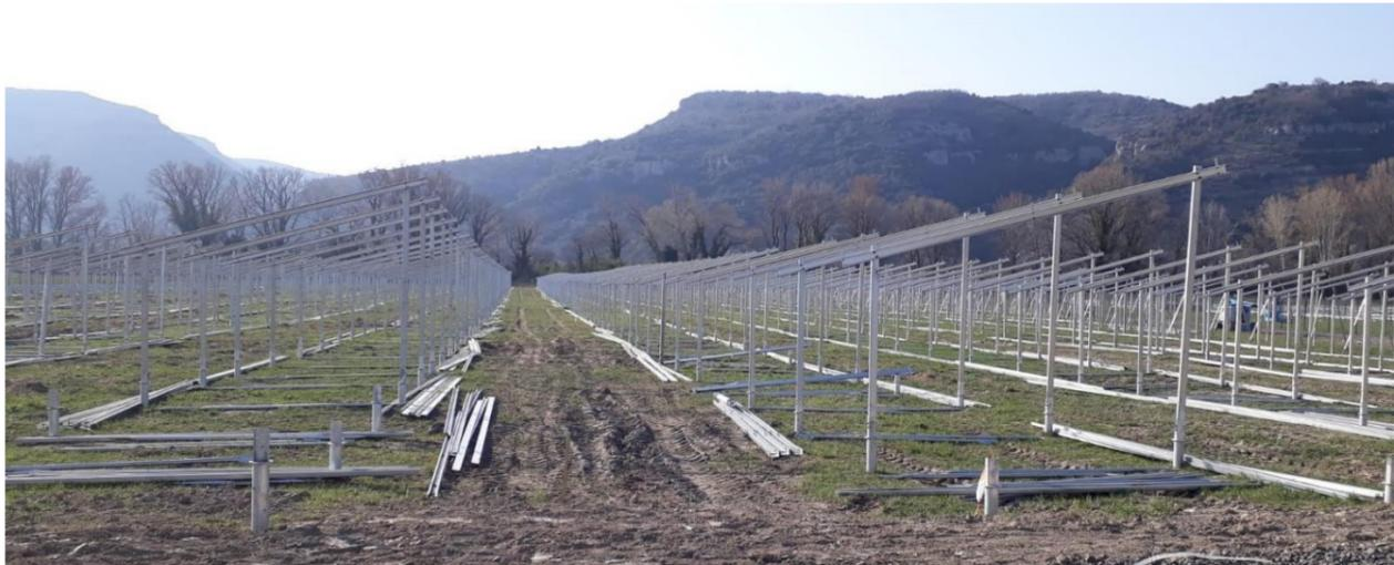
Figure 32 : Exemple de structures et fondations par pieux en acier
