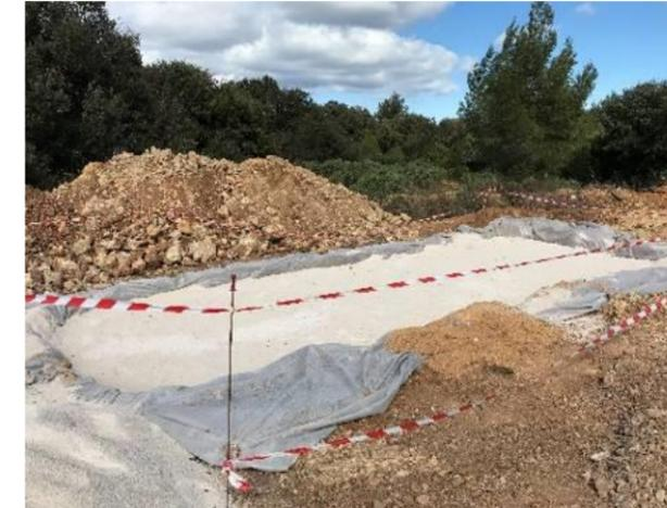
**Figure 49 : Fouille préparée pour la pose d'un poste de conversion/transformation**
