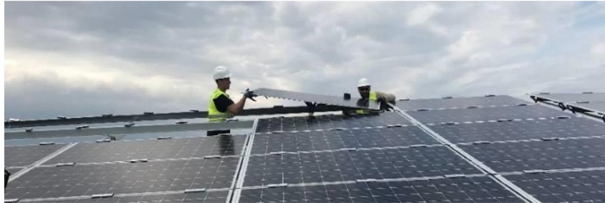
**Figure 47 : Pose des modules**
