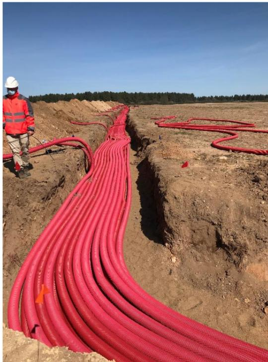
**Figure 48 : Exemple de réalisation de tranchées du raccordement interne**
