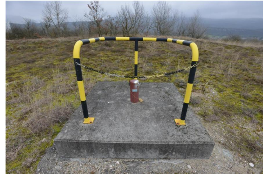
**Figure 64 : Piézomètre de surveillance « 0 SEZa 15 LZ » installé sur le site**
