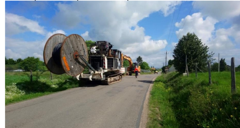
Travaux d'enfouissement de câbles (crédit photo : Ectare)
