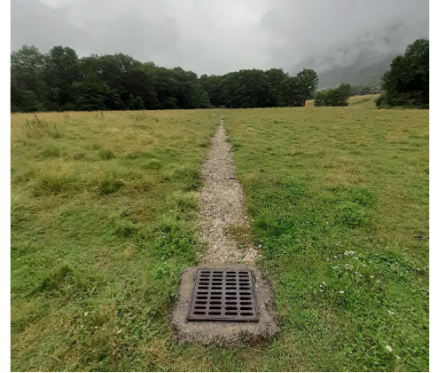
Vue depuis la rigole de collecte des eaux de ruissellement - Source : CORFU Solaire
