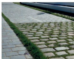
Pavés enherbés sur la Place de la Pointe à Pantin (93)
