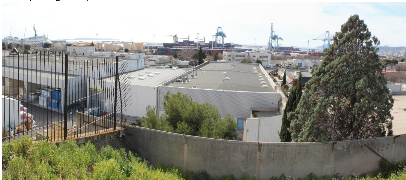
Fig.2 vue du site vers le sud-ouest
