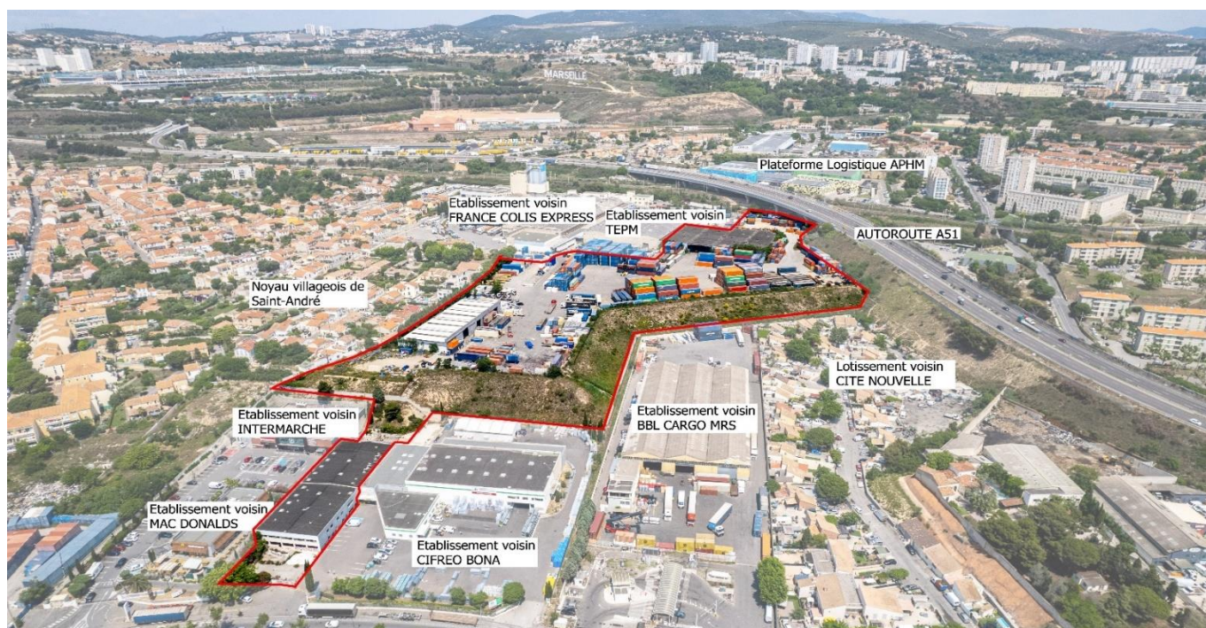
Fig. 7 – Photo aérienne du site vu du littoral, avec indication des voisinages
