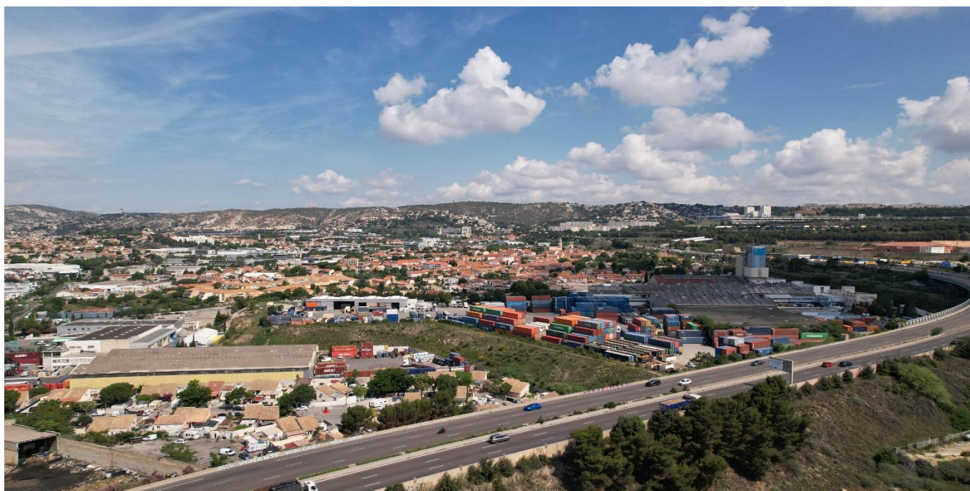
Fig.6 vue aérienne du site depuis le sud
