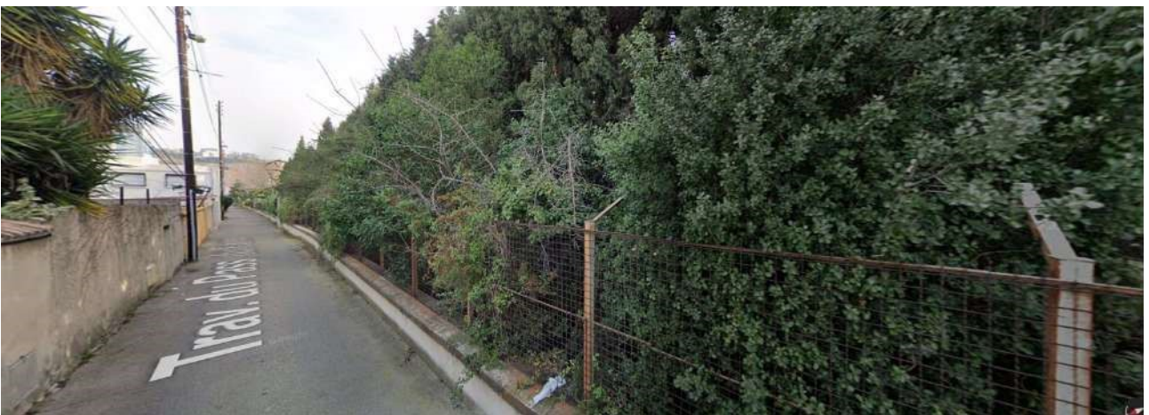
fig.24 : la frange arborée en limite nord du site vu depuis la traverse du pas du faon.
