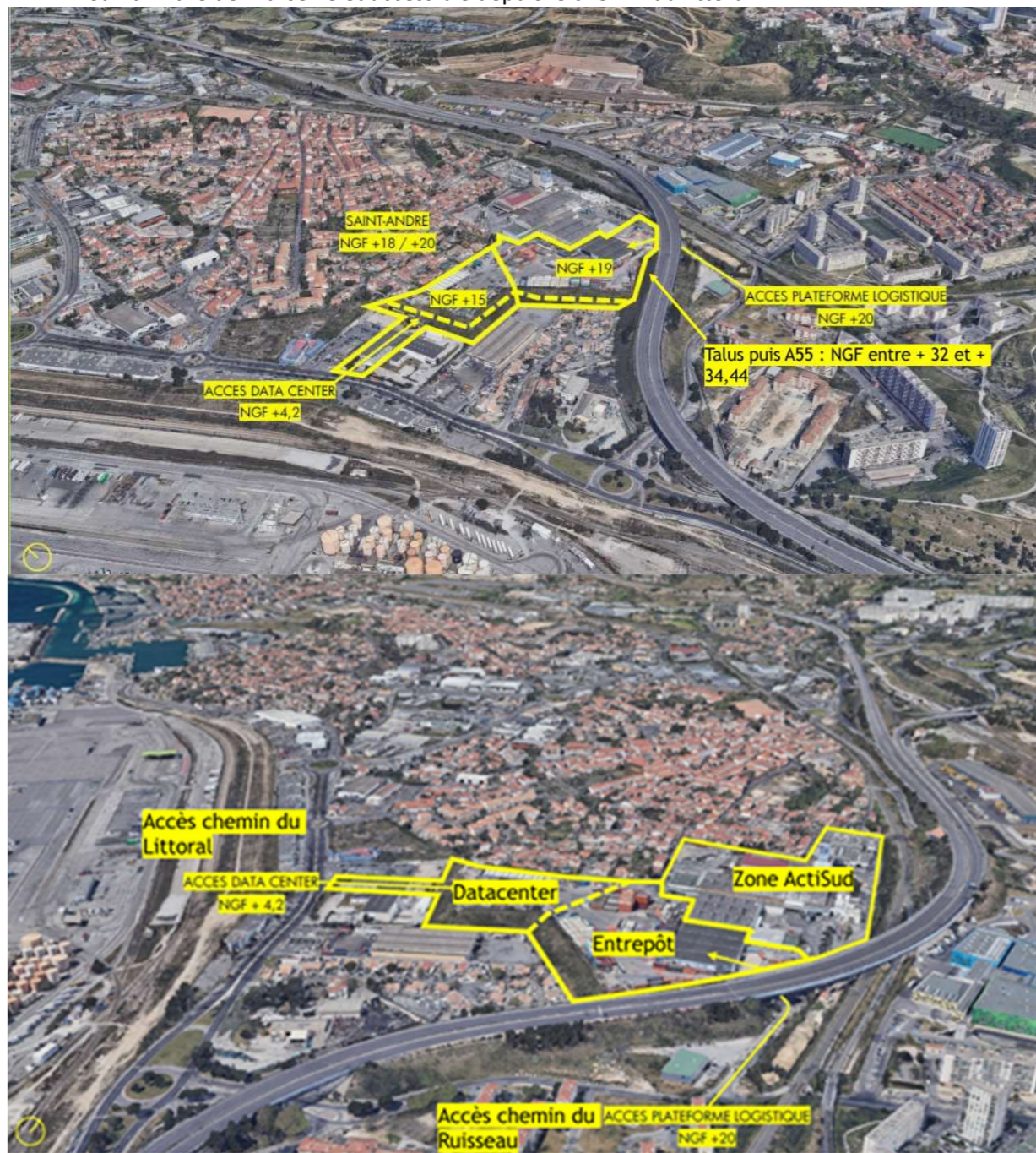
Figure 33 : Site d'implantation du projet
