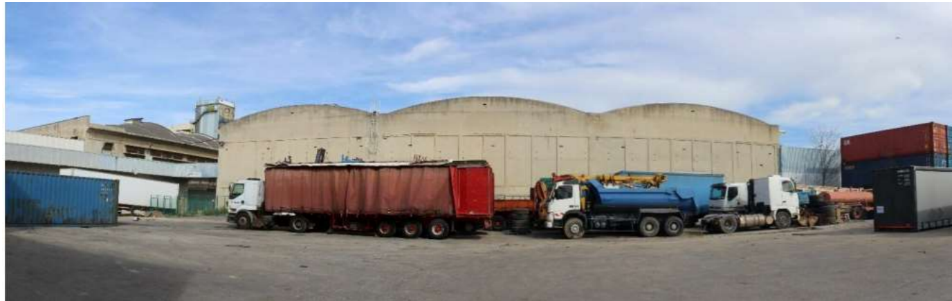
Figure 174 : vue du site vers le nord-est
