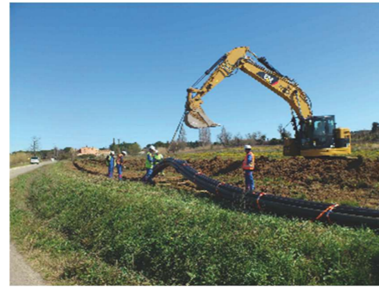
Pose des fourreaux PEHD en pleine terre.
