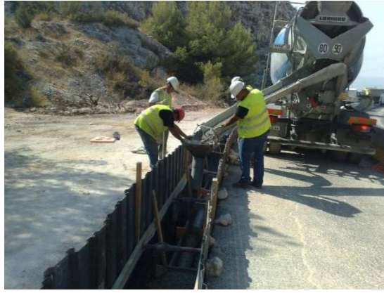
Coulage du béton.
