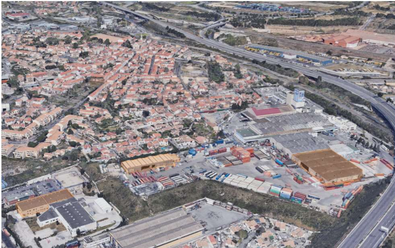
Figure 38 : Bâtiments à démolir
