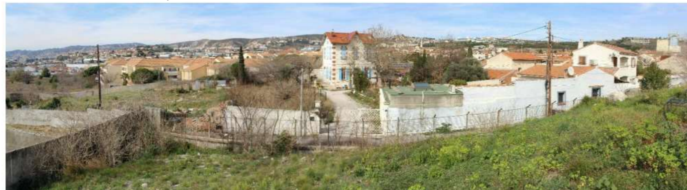
Figure 175 : vue du site vers le nord-ouest et le noyau villageois de Saint André
