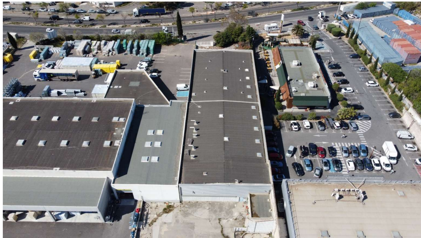
Figure 143 : Ancienne usine aérofarm en cours de désamiantage avant démolition
