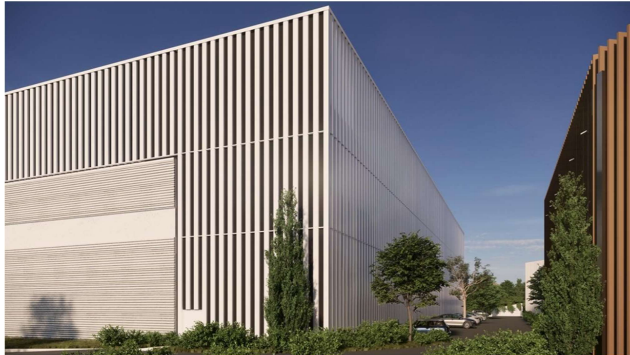
Figure 209 : vue du projet depuis le centre logistique (ngf +15.4) – corps de bâtiment « Actisud ».
