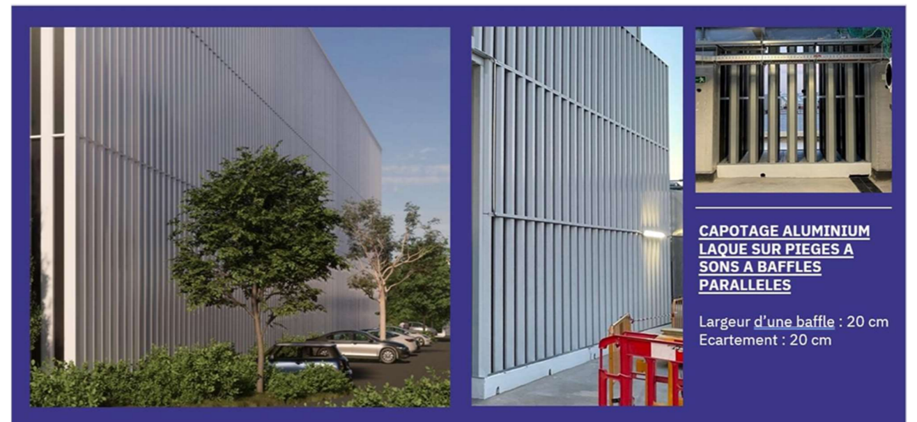
Figure 217 : revêtement en aluminium laqué teinte claire pour le corps de bâtiment « Actisud »
