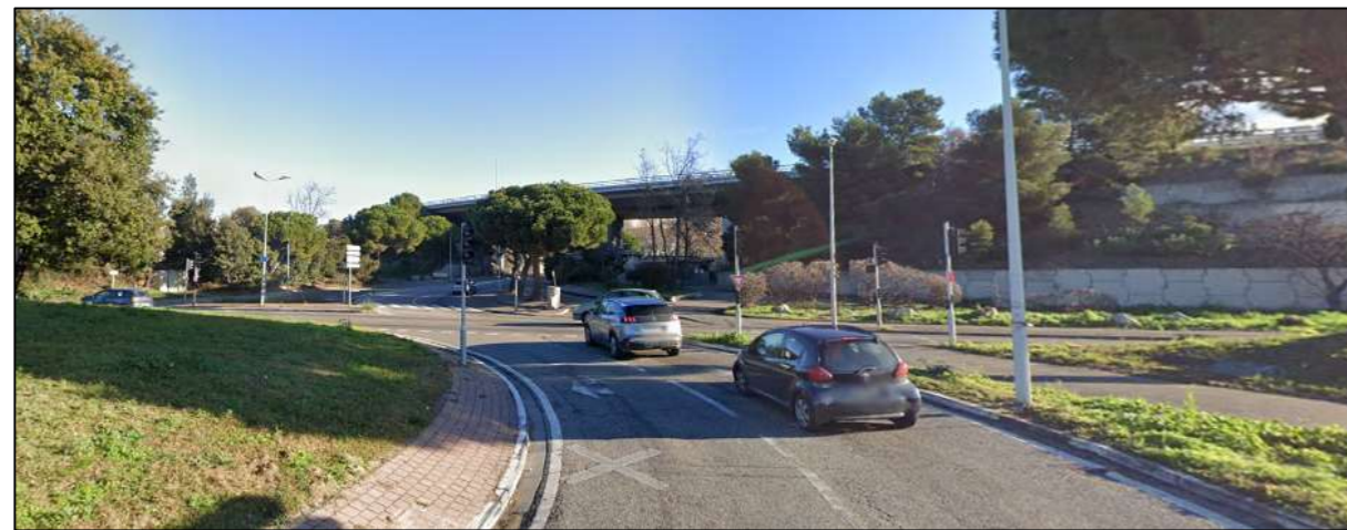
Figure 155 : Rond-point F. Chamant (vue interne vers Chemin du ruisseau Mirabeau)
