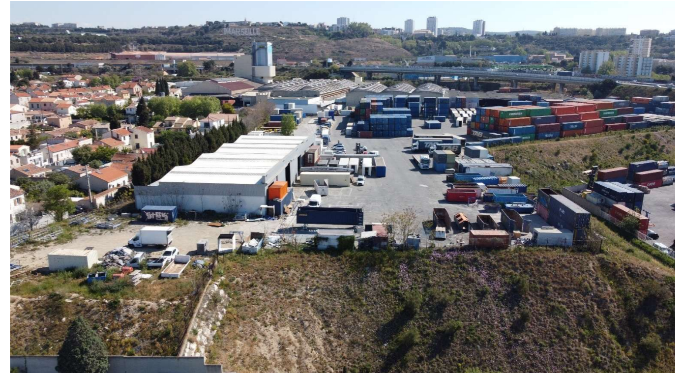
Figure 34 : Zone Actisud bâtie sur un remblai de 15 m de haut
