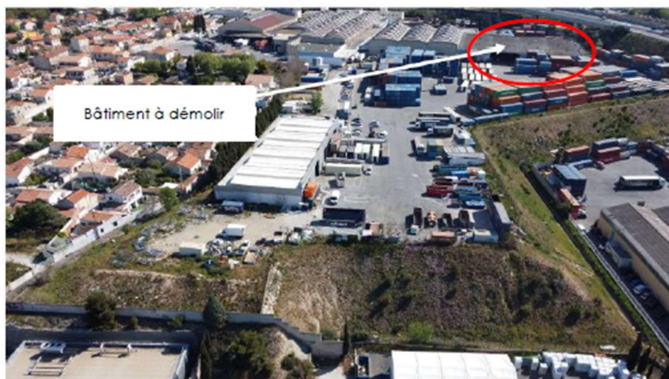
Figure 1 : Bâtisse à démolir – (Segro)
