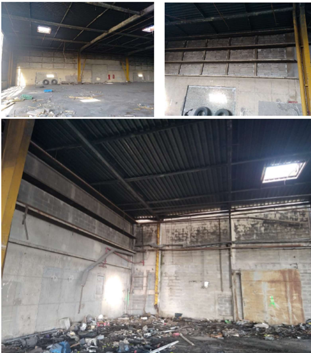
Figure 4 : intérieur muré du hangar. (Ecotonia)
