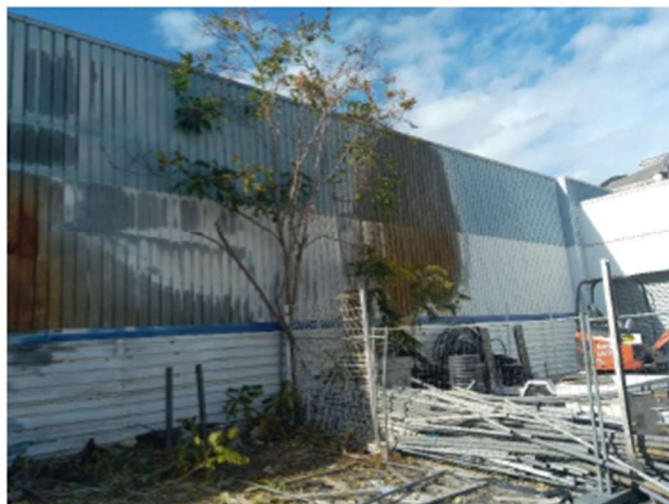
Figure 5 : Vue Nord du hangar (Ecotonia)
