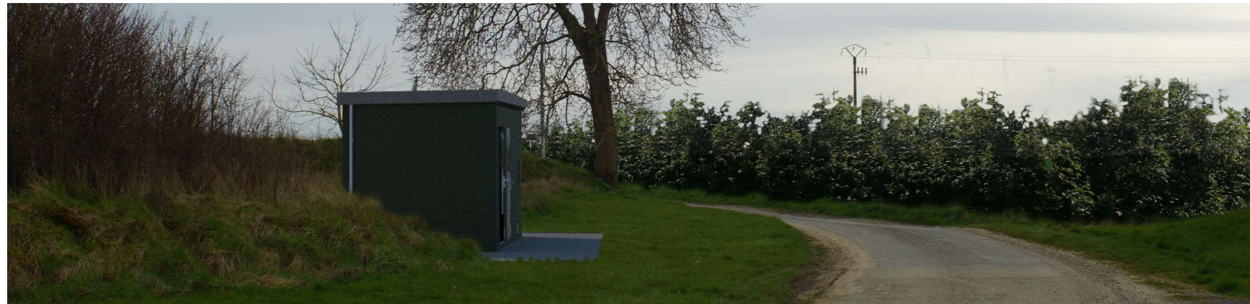
Figure 86 : Photo de la sortie de la Ferme de Party – Etat projeté et mesures ERC - (source : ATER ENVIRONNEMENT, 2023)
