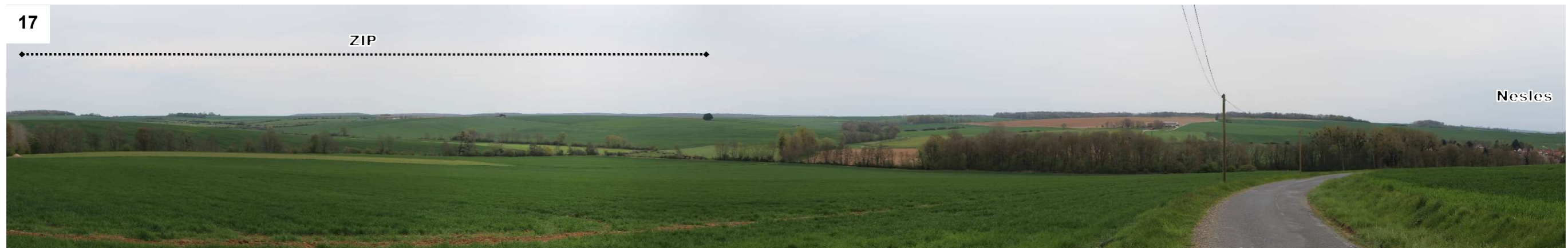
Figure 20 : Vue depuis les abords de la départementale 79, il existera une covisibilité entre le village de Nesles et le futur projet (source : ATER Environnement, 2021)
