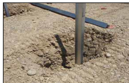
Figure 6 : ancrage par pieux battus
