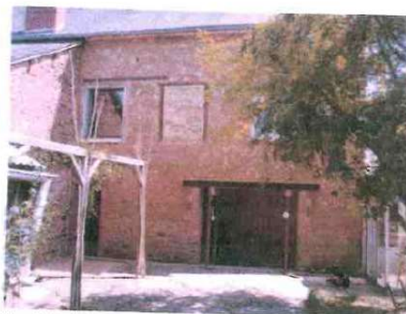
Vue de la façade après rénovation
