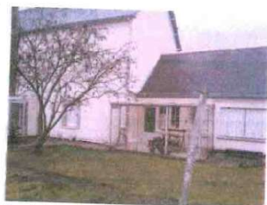
Vue de la façade arrière avant rénovation
