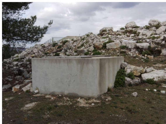
Chambre des forages F3 et F4
