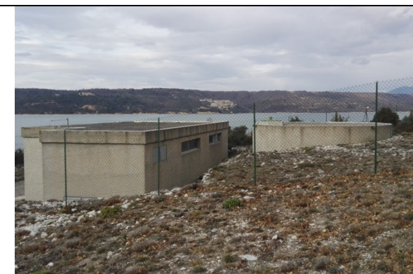
STATION DE TRAITEMENT ET BACHE DE REPRISE
