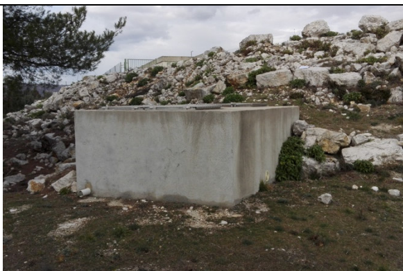
CABANE BETONNEE DES FORAGES F3 ET F4
