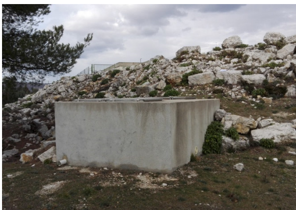
CABANE BETONNEE DES FORAGES F3 ET F4
