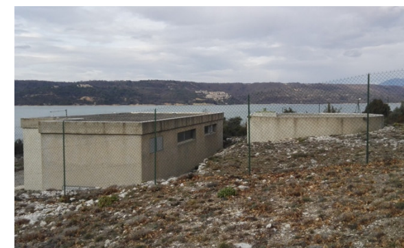
STATION DE TRAITEMENT ET BACHE DE REPRIS
