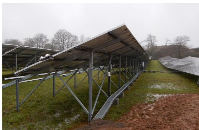
Photographie 9 : Exemple de liaisons électriques aériennes (Source : ENCIS Environnement)
