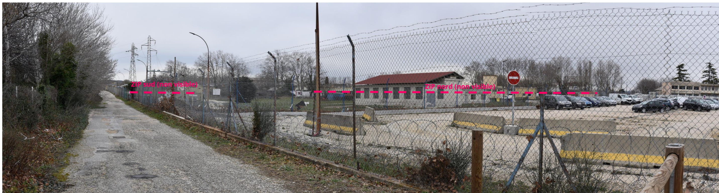
Photographie 15 : Vue en direction du site d'étude depuis les limites sud-est d'Eurengo et le chemin privatisé, à 160 m de la ZIP (vue 3 de la carte précédente)
