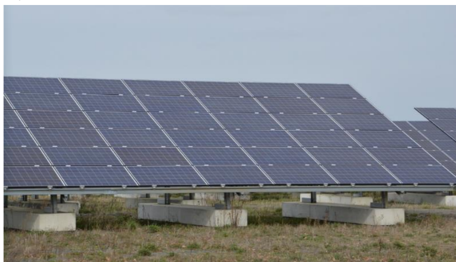
Photographie 7 : Exemple de fixation avec des plots en béton (longrines) (source : ENCIS Environnement)
