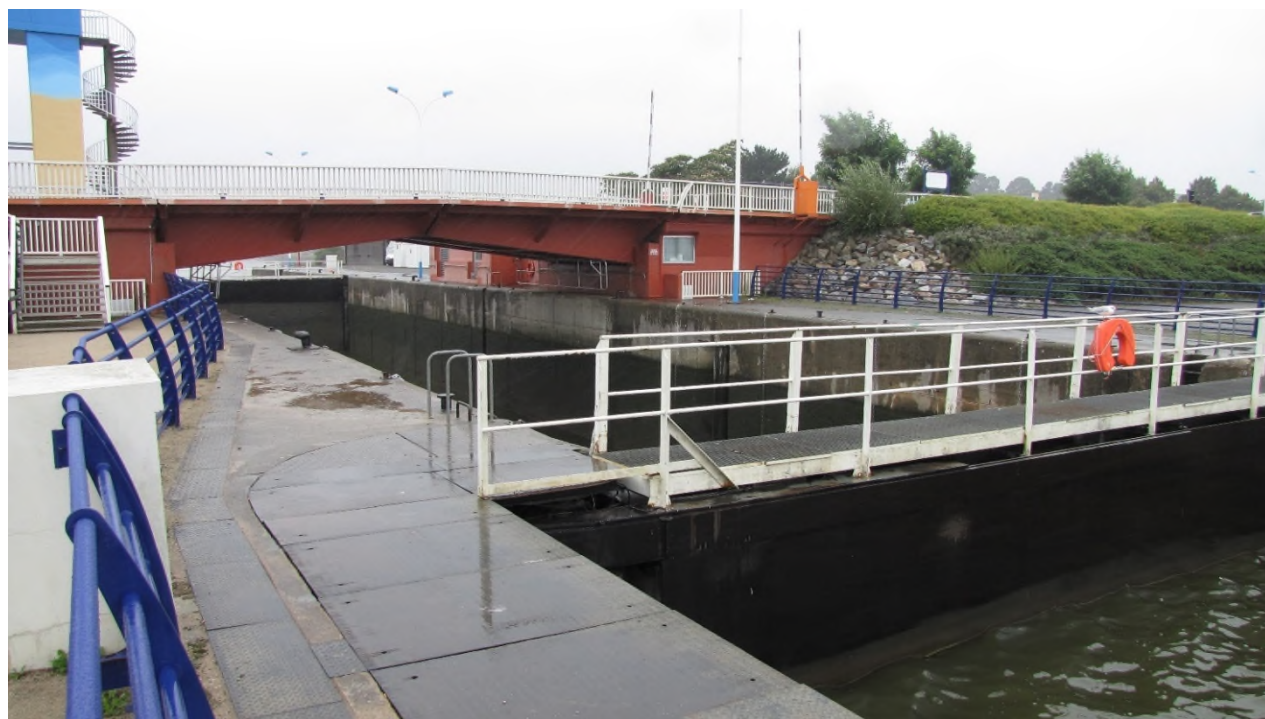
Figure 8 : Vue de l'écluse en aval de la porte intermédiaire vers l'amont - Source : ARTELIA
