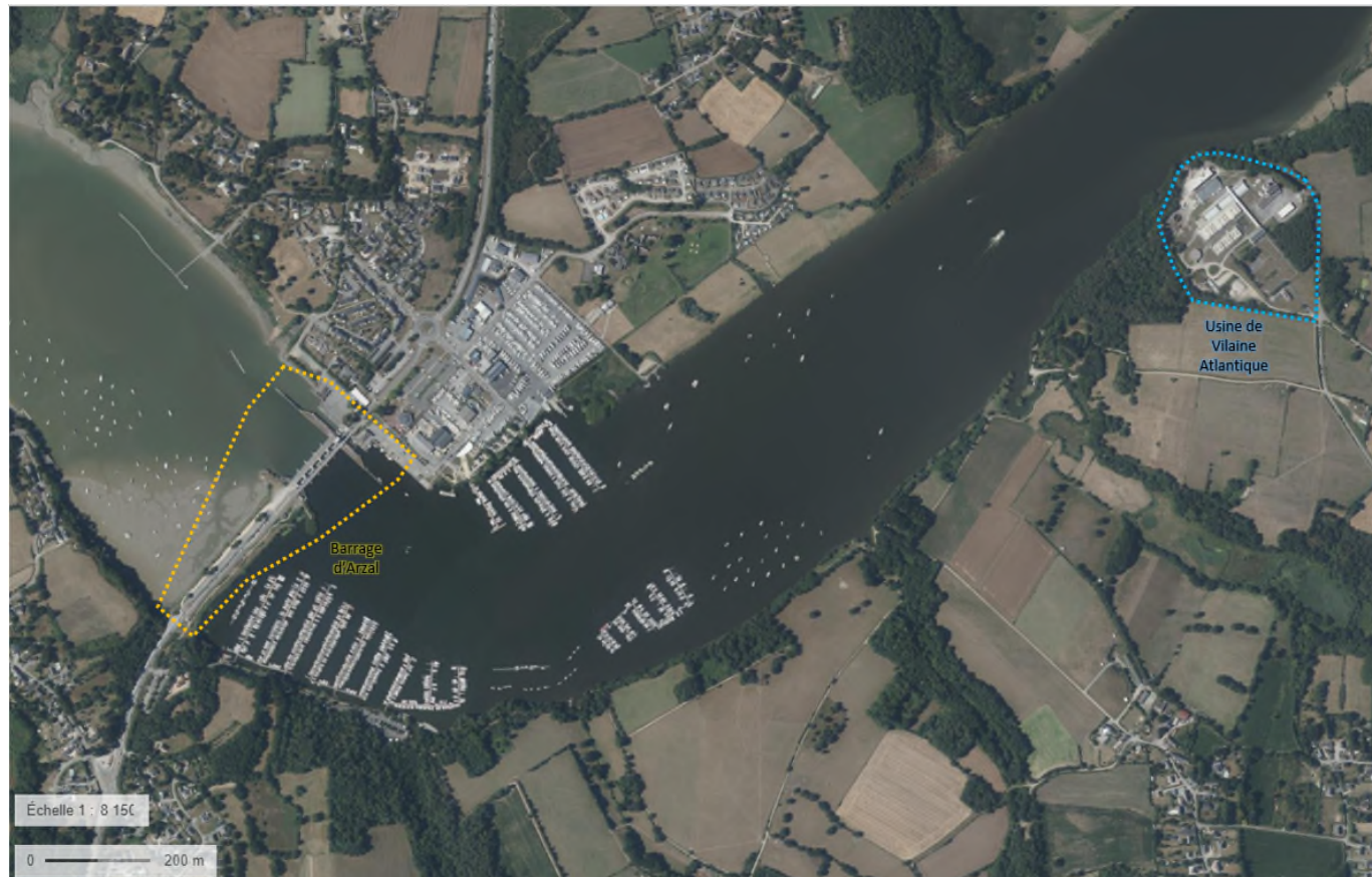
Figure 4 : Vue aérienne du barrage et de l'usine de Vilaine Atlantique
