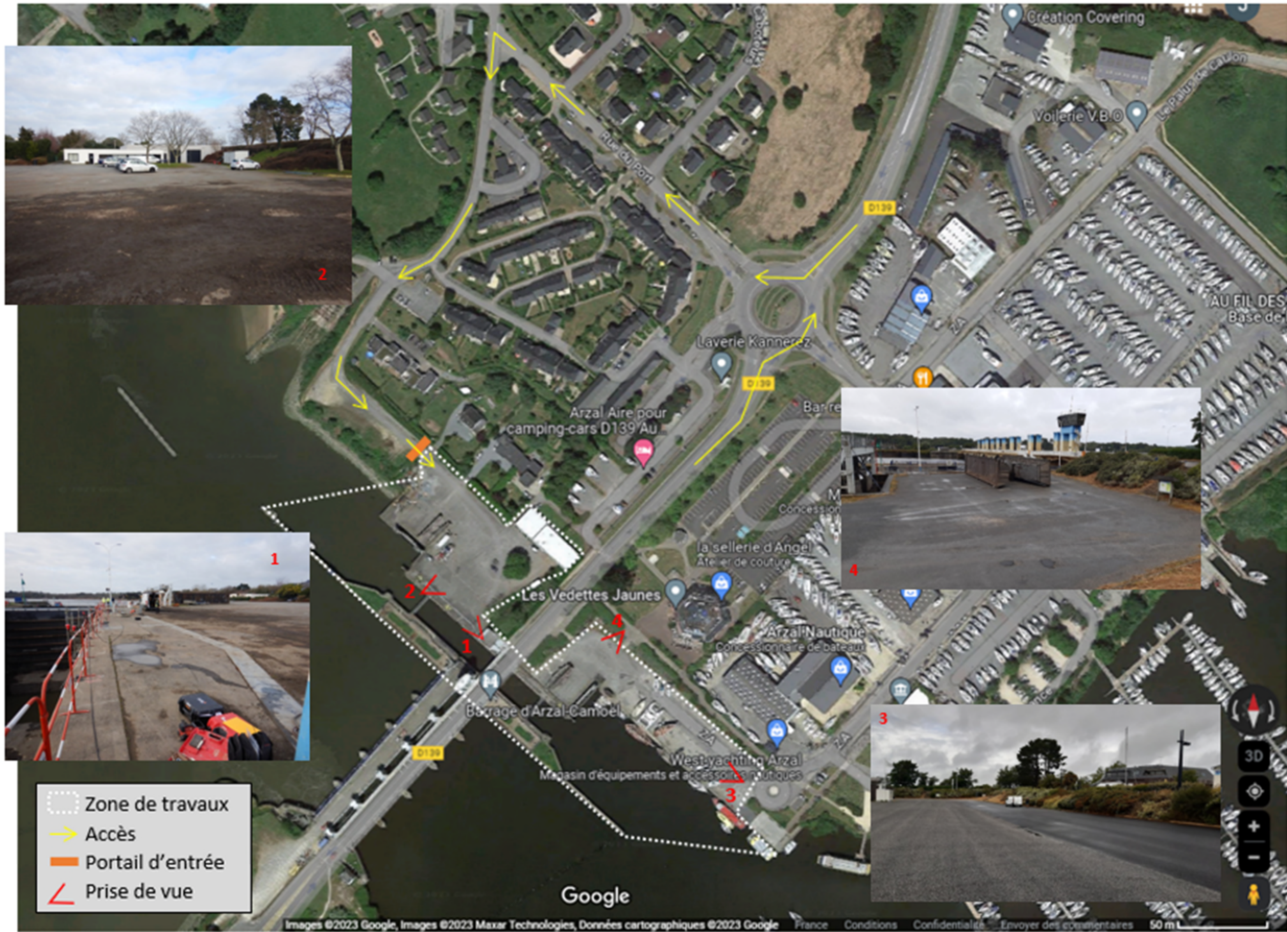
Figure 16 : Vue aérienne de la zone de travaux ainsi que les accès prévus
