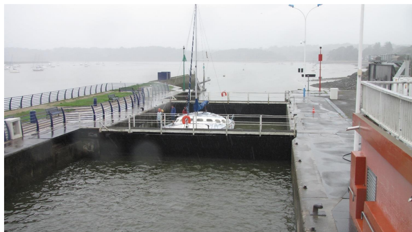
Figure 12 : Vue de l'écluse en amont de l'ouvrage vers l'estuaire avec (à gauche) — Bavec bateau attendant l'ouverture de l'écluse (à droite) - Source : ARTELIA
