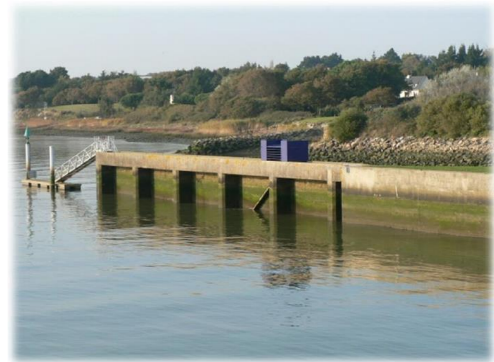
Figure 17 : Passe à anguilles construite en 2006 en rive droite du barrage d'Arzal (rampe plongeant dans l'estuaire et local de piégeage) – Source : Eaux&Vilaine
