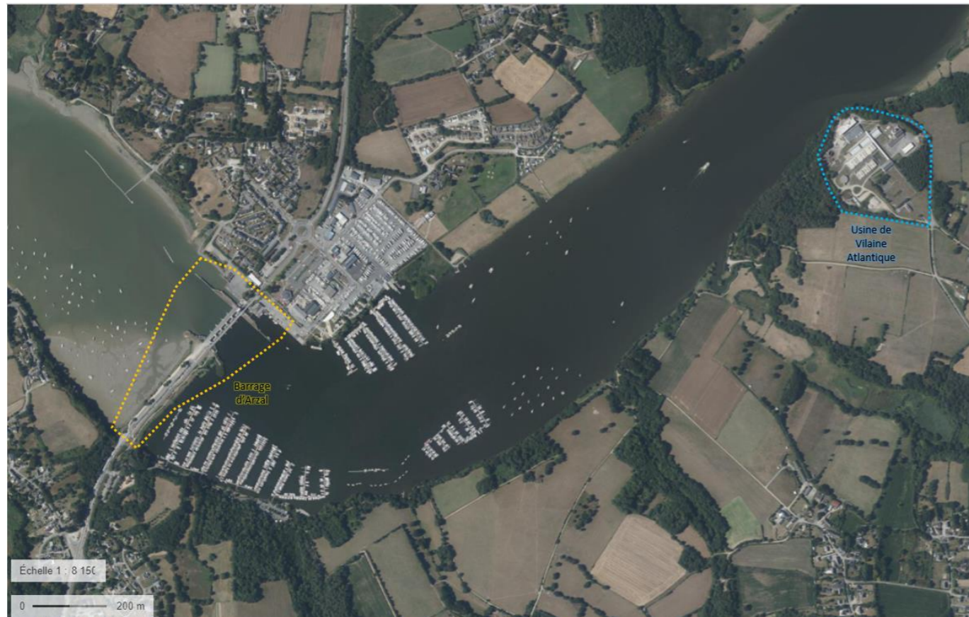
Figure 4 : Vue aérienne du barrage et de l'usine Vilaine Atlantique
