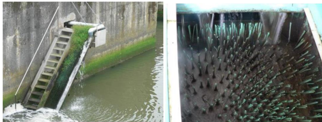
Figure 15 : Rampe de la passe à anguilles au droit des gabions (à gauche) - Substrat de reptation des anguilles (à droite)
