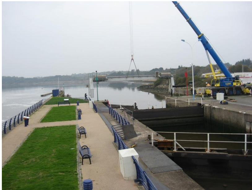
Figure 89 : Mise en œuvre du portique pour la mise en place du batardeau aval
