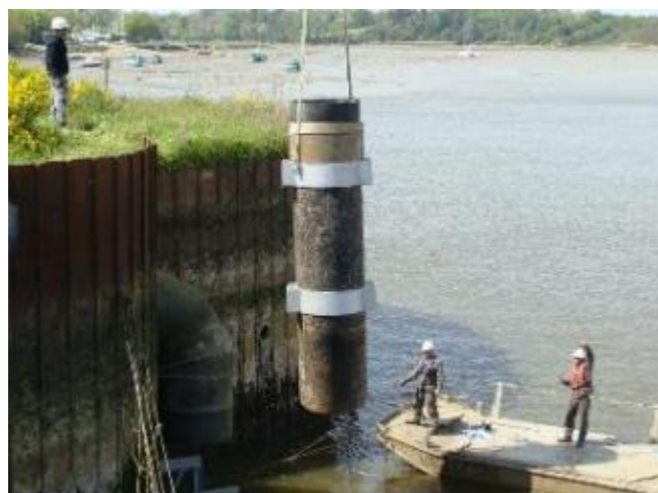
Figure 25 : Installation d'un siphon à proximité des gabions aval
