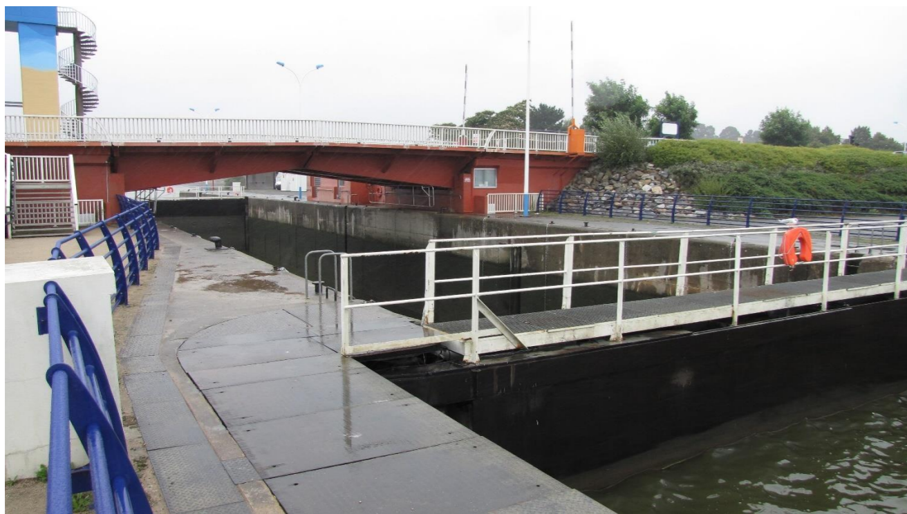
Figure 11 : Vue de l'écluse en aval de la porte intermédiaire vers l'amont - Source : ARTELIA
