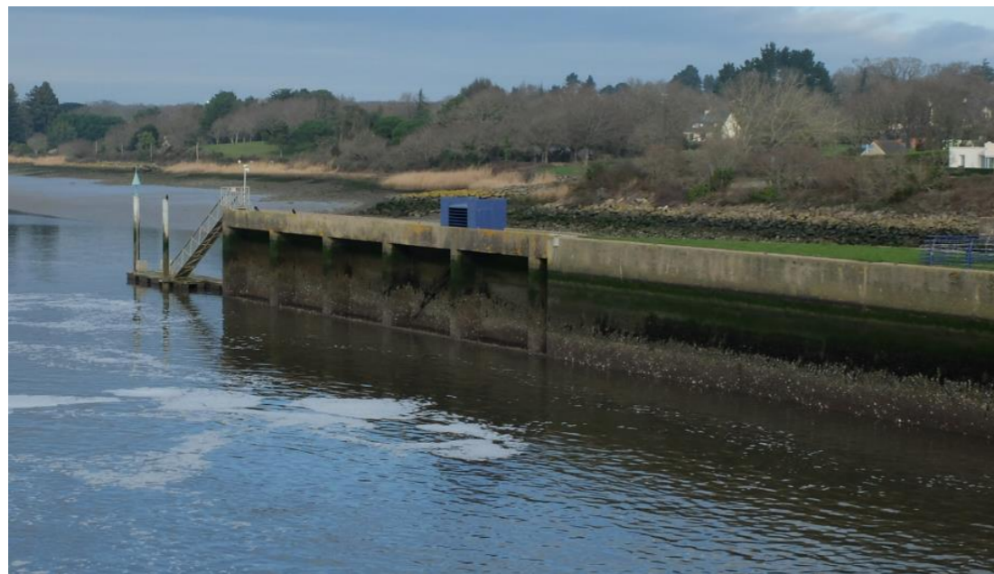
Figure 19 : Mur guide eau et bâti blindé
