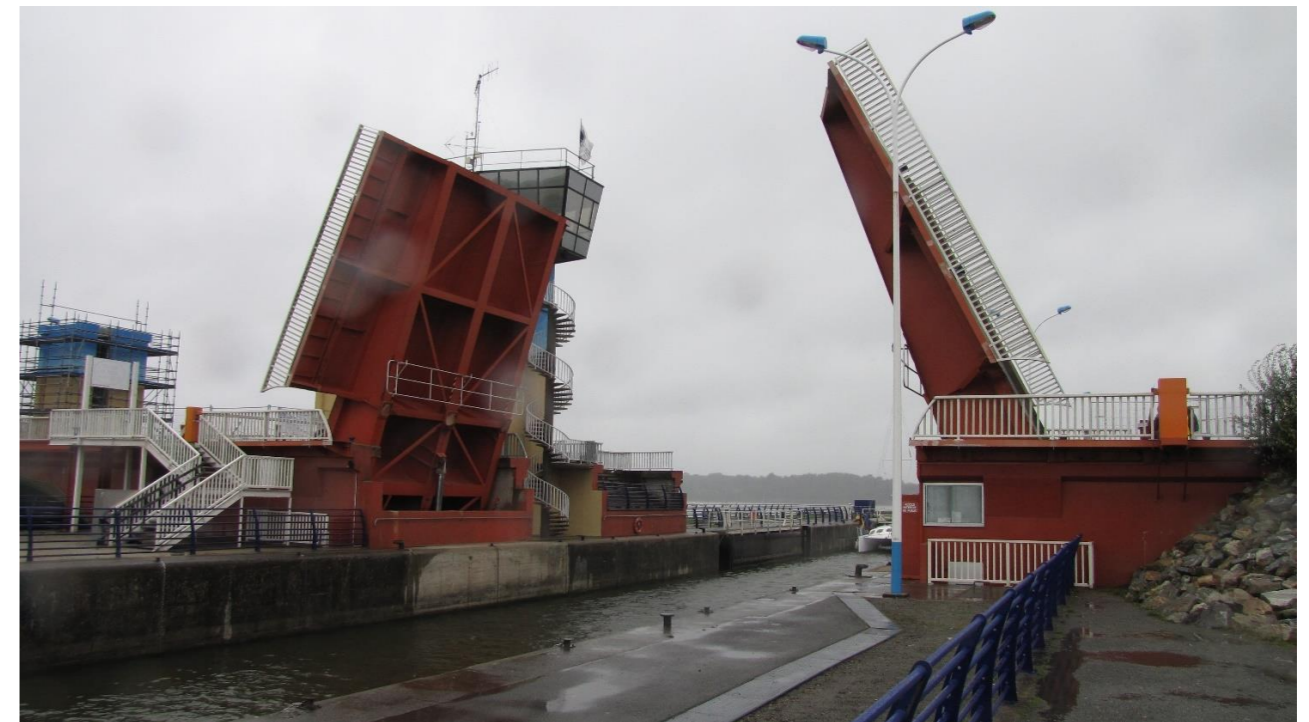
Figure 32 : Pont mobile levant permettant le passage des bateaux
