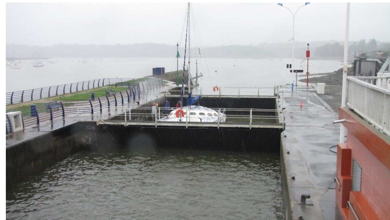
Figure 6 : Vue de l'écluse vers l'estuaire avec un bateau attendant l'ouverture de l'écluse - Source : ARTELIA
