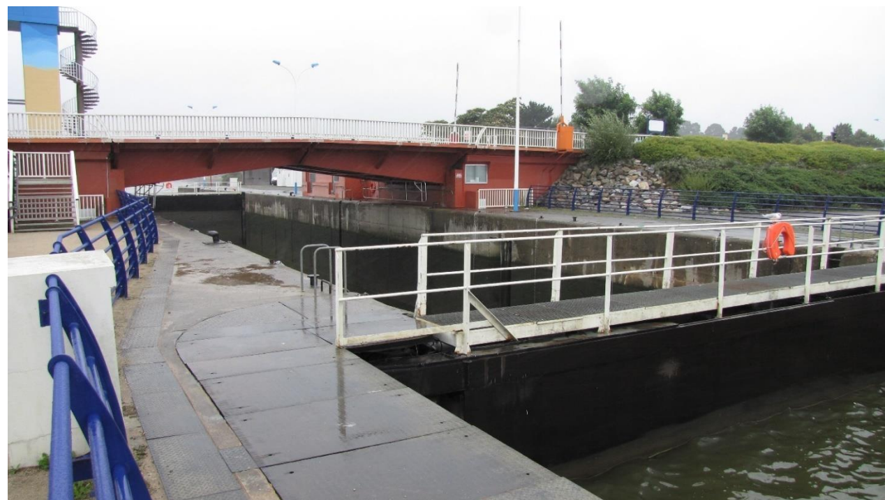
Figure 5 : Vue de l'écluse en aval de la porte intermédiaire vers l'amont - Source : ARTELIA
