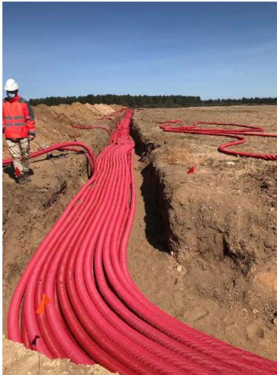
Figure 39 : Exemple de réalisation de tranchées du raccordement interne (Source : EDF Renouvelables)
