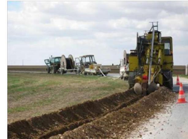
Figure 41 : Réalisation de tranchées du raccordement externe dans l'emprise des voies existantes (Source : EDF Renouvelables)
