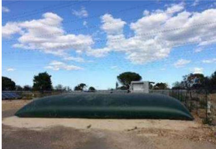
Figure 31 : Exemple d'une citerne souple (Source : EDF Renouvelables)
