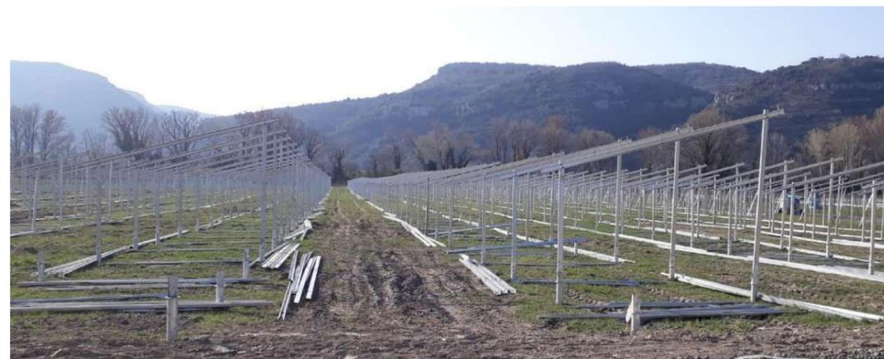
Figure 22 : Exemple de structures et fondations par pieux en acier
