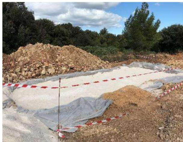
Figure 40 : Fouille préparée pour la pose d'un poste de conversion/transformation (Source : EDF Renouvelables)
