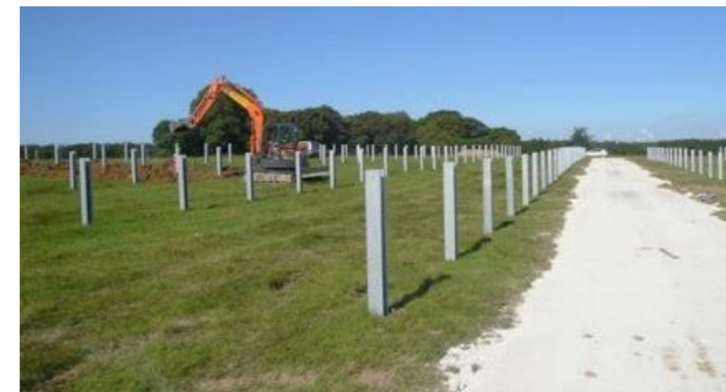
Travaux de montage des supports des modules (crédit photo : EDF RE)
