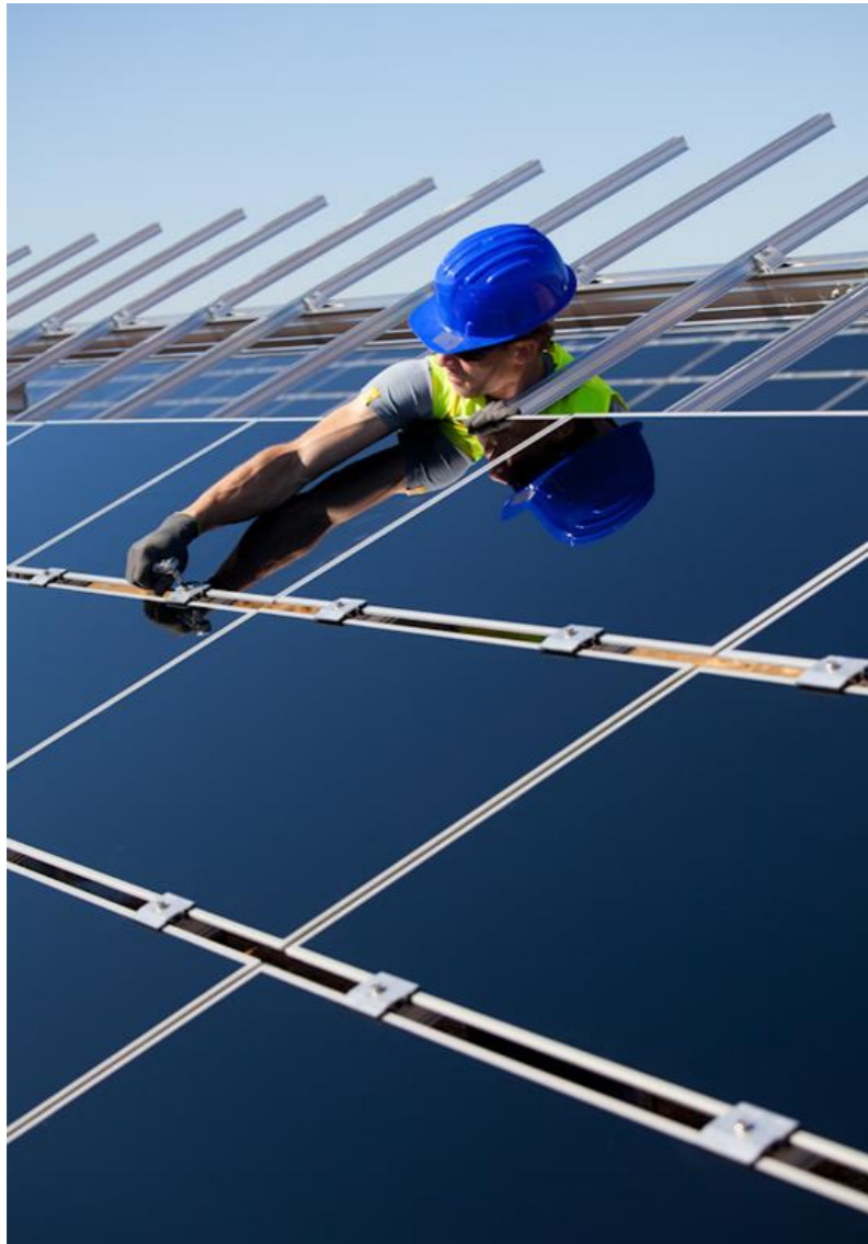
Remplacement de module (crédit photo EDF Renewables)
