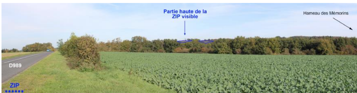
Vue 11 depuis la RD989 aux abords des Mémorins (Source : Etude d'impact, CESAME, juin 2023)
