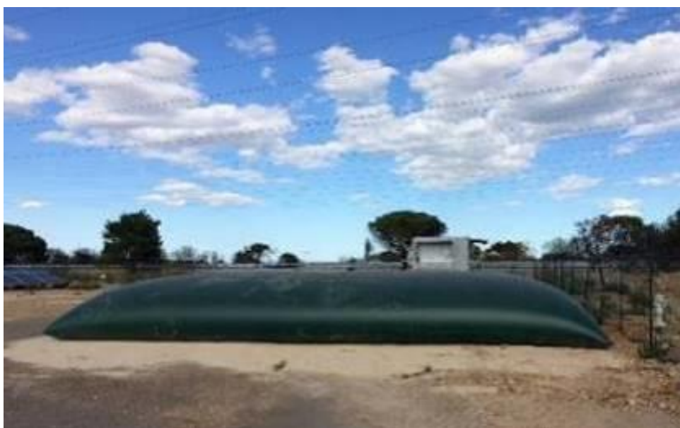
Exemple d'une citerne souple (Source : EDF Renouvelables)
